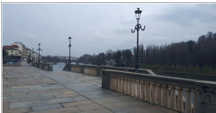
Foto 7 – Accesso blocco scala sud da c.so Cairoli
