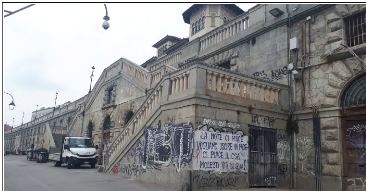
Foto 5 – Blocco scala nord (in corrispondenza di via G.Giolitti)
