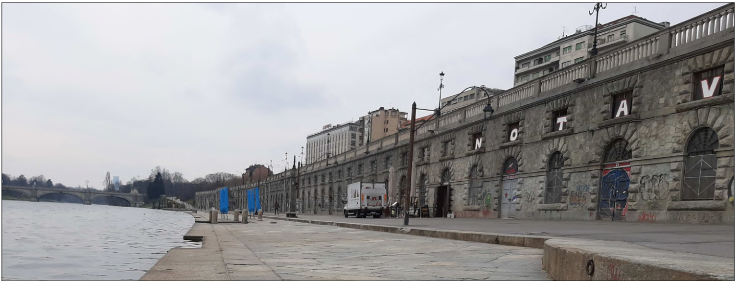
Foto 2 – Vista generale dei Murazzi dalla piarda in corrispondenza del blocco scala nord (da nord a sud)
