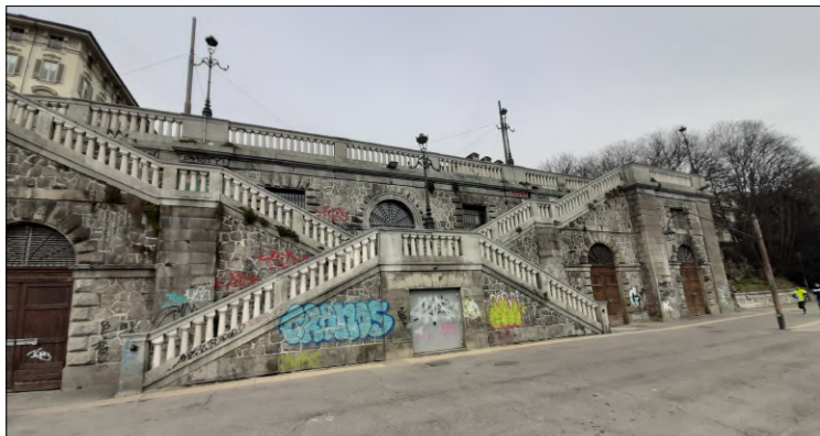
Foto 17 – Blocco scala in corrispondenza di c.so San Maurizio
