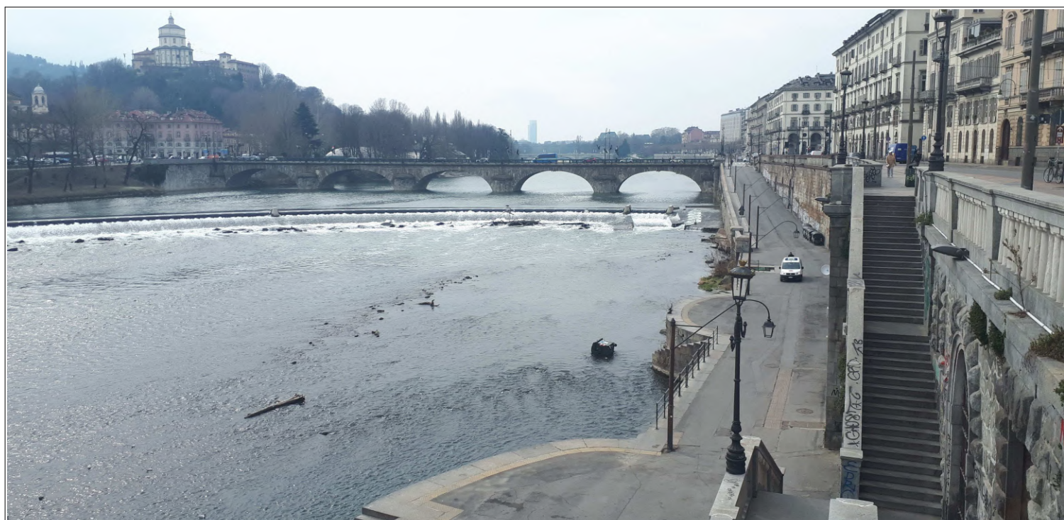
Foto 14 – Vista generale dei Murazzi dal Lungo Po L.Cadorna in corrispondenza del blocco scala all'altezza di c.so San Maurizio
