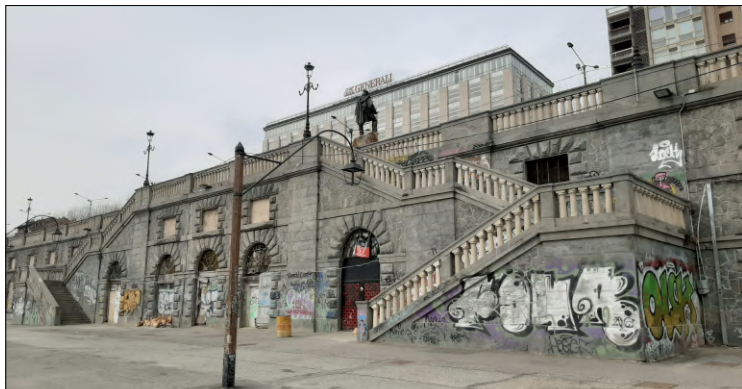
Foto 6 – Blocco scala sud (in corrispondenza di via dei Mille)
