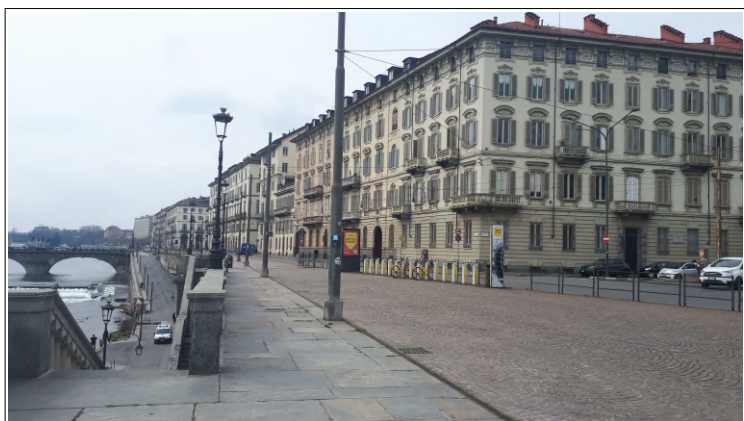
Foto 19 – Area di attesa in corrispondenza del blocco scala
