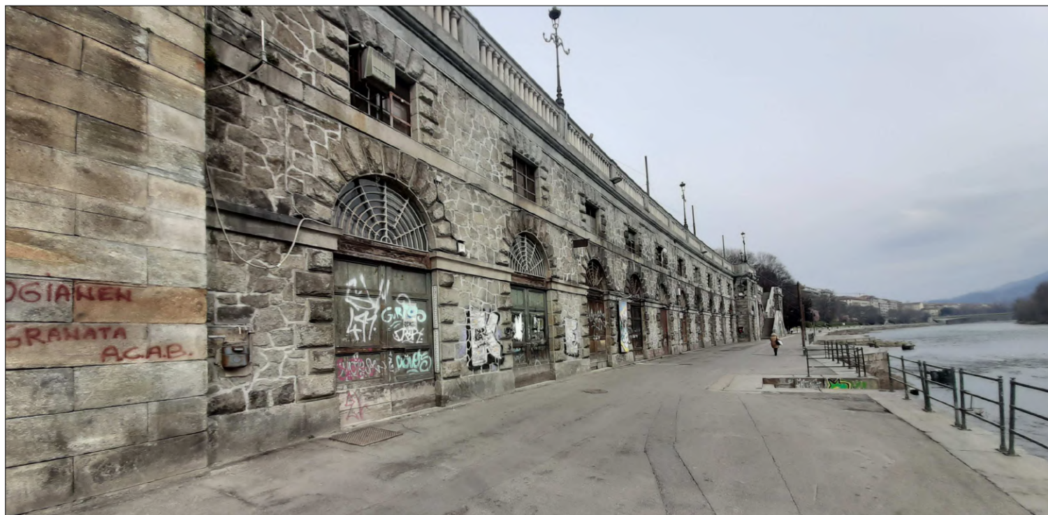
Foto 13 – Vista generale dei Murazzi a nord del Ponte Vittorio Emanuele I (da sud a nord)
