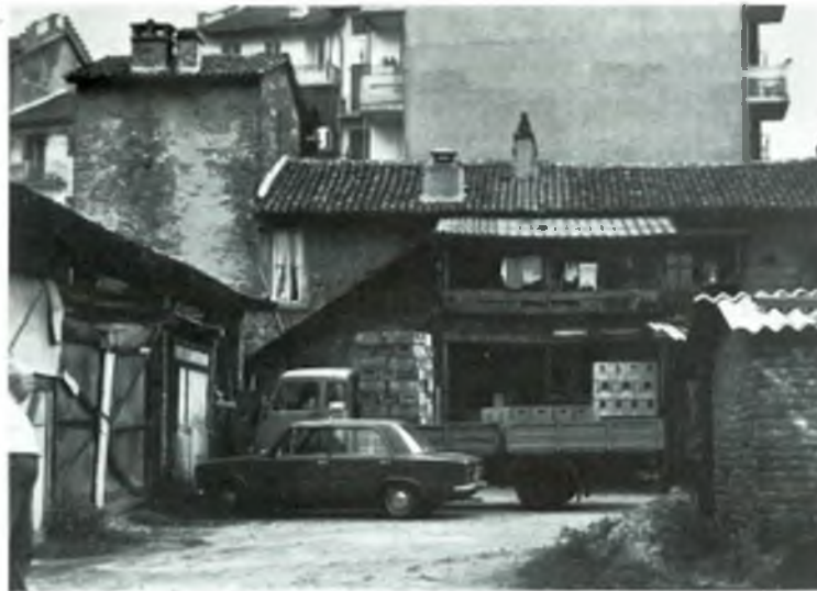
197. Il presumibile « castello del Lingotto », lato nord, visto dal cortile di v. Passo Buole 60. 1983. L'edificio, abitato sino all'ultimo, è stato demolito dalle fondamenta nel 1986.
