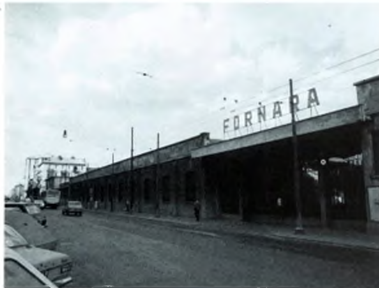
100. La manica vecchia della Fornara lungo via Genova, risalente ai primi anni del nostro secolo. 1984.
