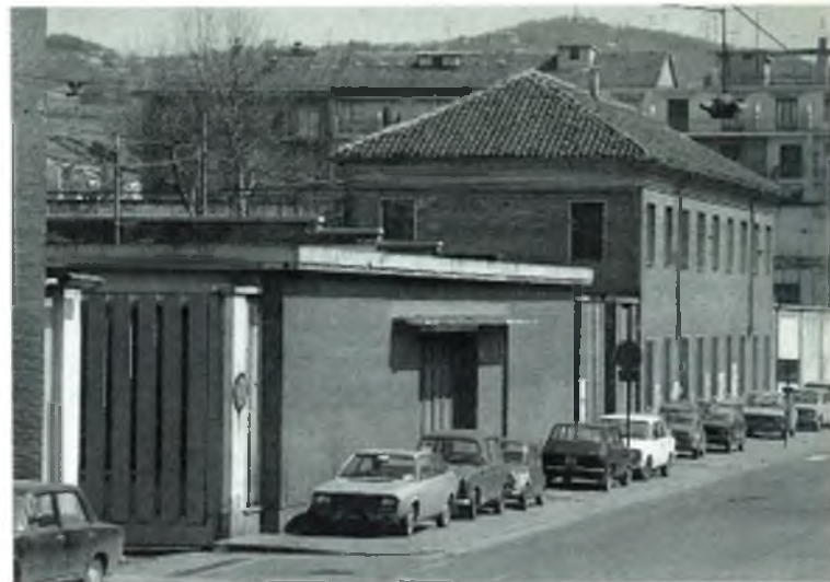
67. Probabile fabbricato superstite del complesso agricolo del Robilant su via Passo Buole. Stato attuale.
