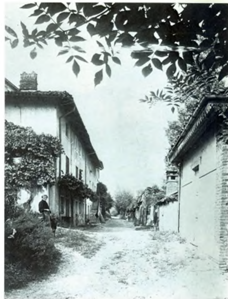
43. «Casamicciola». La casa propriamente detta «Casamicciola» è quella lunga, sulla sinistra: se ne vedono la facciata est, verso valle (= verso Po), e la testata sud; la casa aveva tre piani verso valle e due verso monte. A destra si vede il ciabòt dei lavandai Zeppegno. La vecchietta usa come sporta una grossa latta di conserva di pomodoro. 1930 circa.
