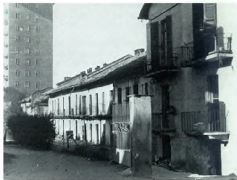
58. La «Regia Nave» (cascina delle Basse di Sotto) vista da via Onorato Vigliani, mentre inizia la demolizione. 1952 circa.
