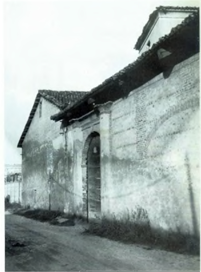
15. Cascina Maina: portone su strada Basse del Lingotto (parte di fabbricato oggi non più esistente). 1969.
