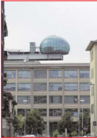
Scorcio del Centro Commerciale 8 Gallery. Sul tetto, la Bolla di Renzo Piano (2005)
