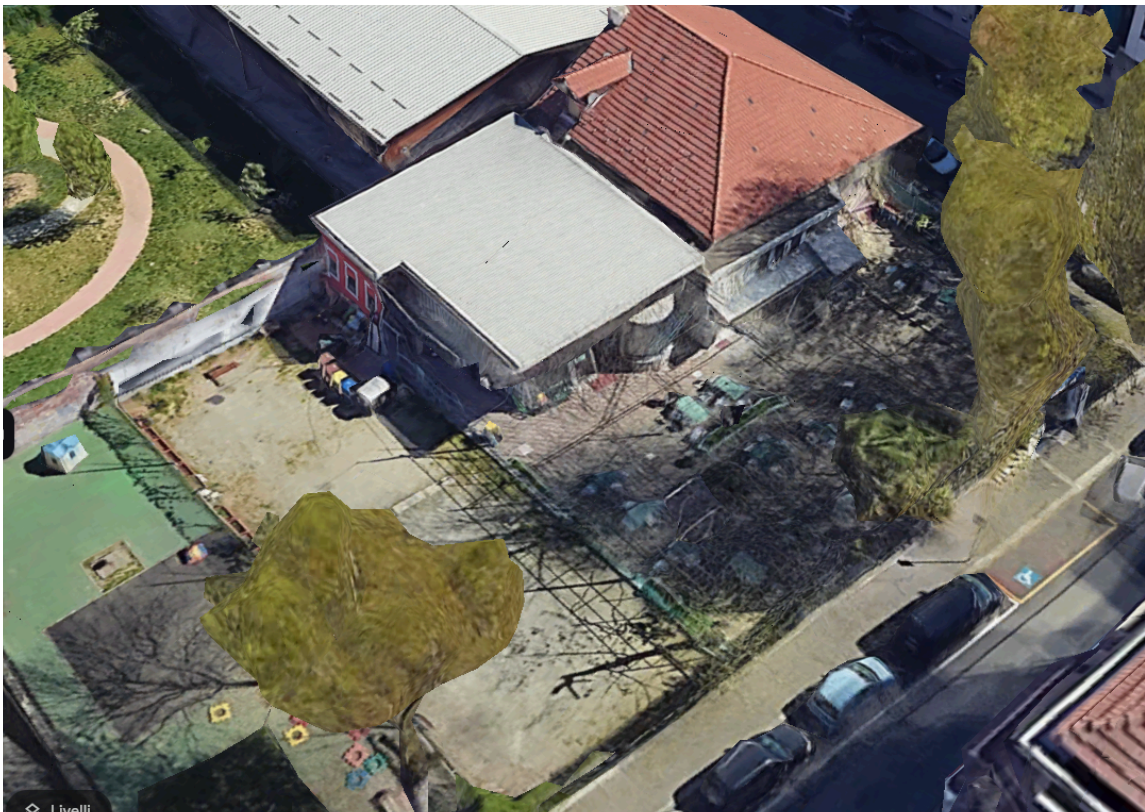
Vista impianto da Google earth
