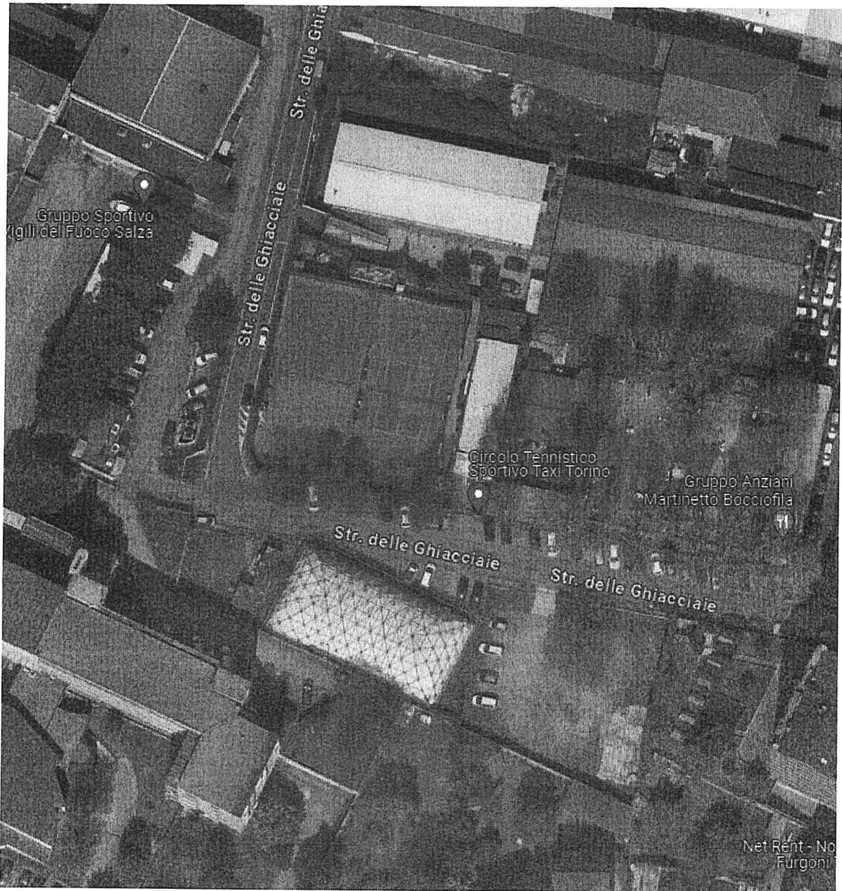
Fotografia aerea dell'impianto
