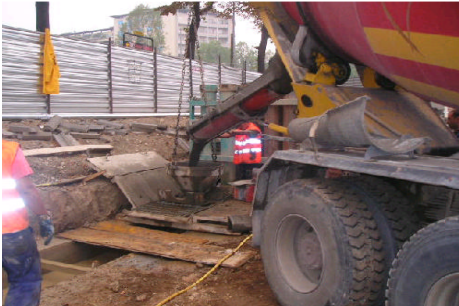
Foto 207-208 : realizzazione diaframmi rampa su c.so Lecce (lato ovest)
