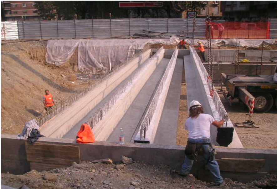
Foto 201-202 : varo travi impalcato lato c.so Trapani
