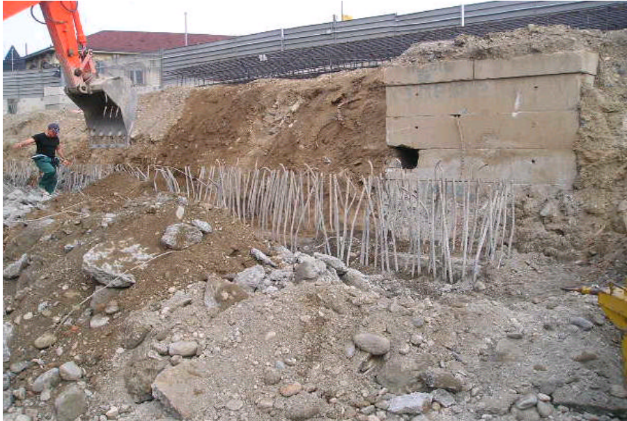
Foto 205-206 : scapitozzatura diaframmi impalcato su piazza Rivoli (fase1)
