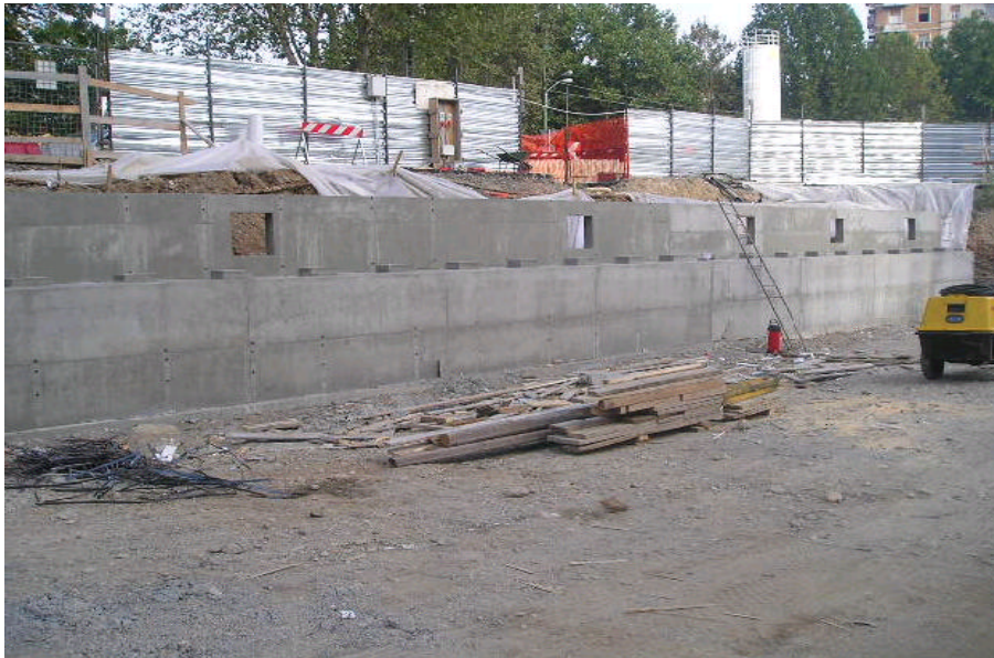
Foto 199-200 : ultimazione banchettone e paraghiaia impalcato lato c.so Trapani
