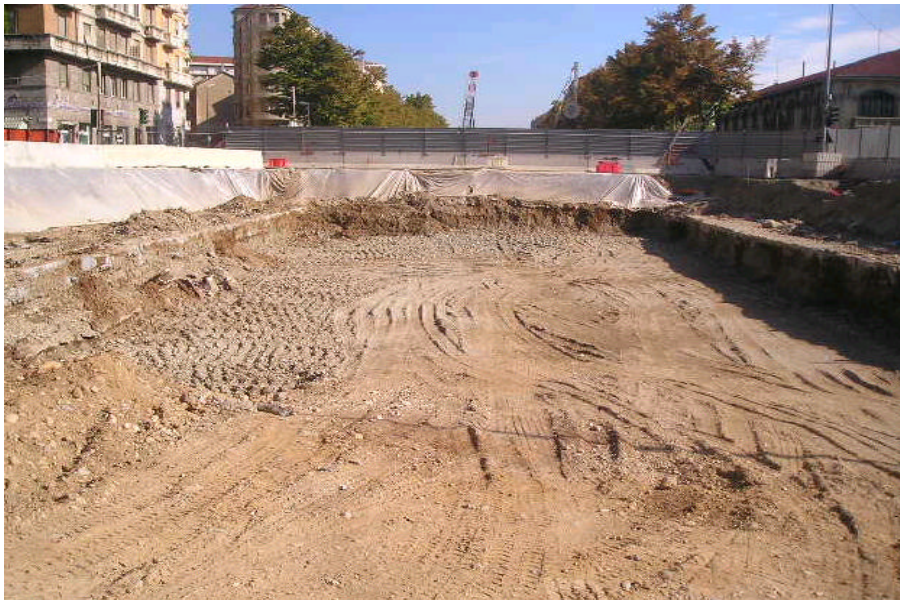
Foto 203-204 : scavo di approfondimento impalcato su piazza Rivoli (fase1)
