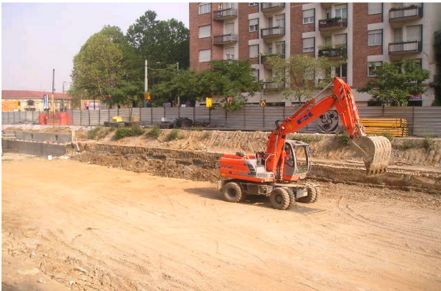
Foto 191-192 : scapitozzatura diaframmi lungo la rampa su corso Trapani
