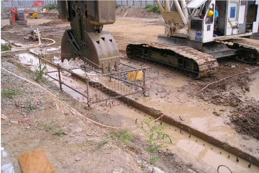
Foto 195-196 : ultimazione diaframmi rampa su c.so Trapani
