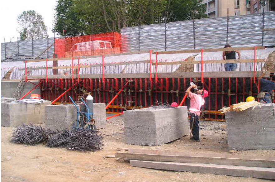
Foto 197-198 : realizzazione banchettone e paraghiaia impalcato lato c.so Trapani
