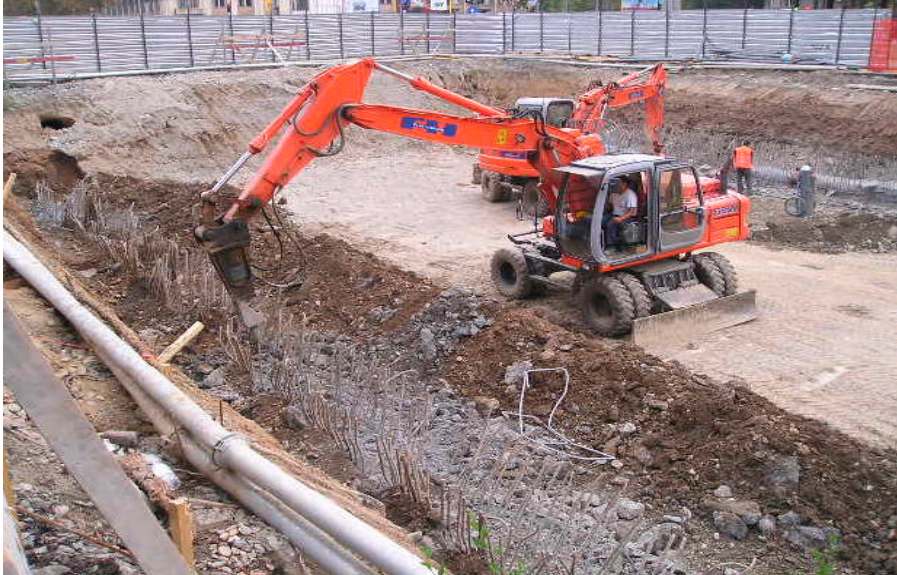
Foto 193-194 : scapitozzatura diaframmi lungo la rampa su corso Trapani
