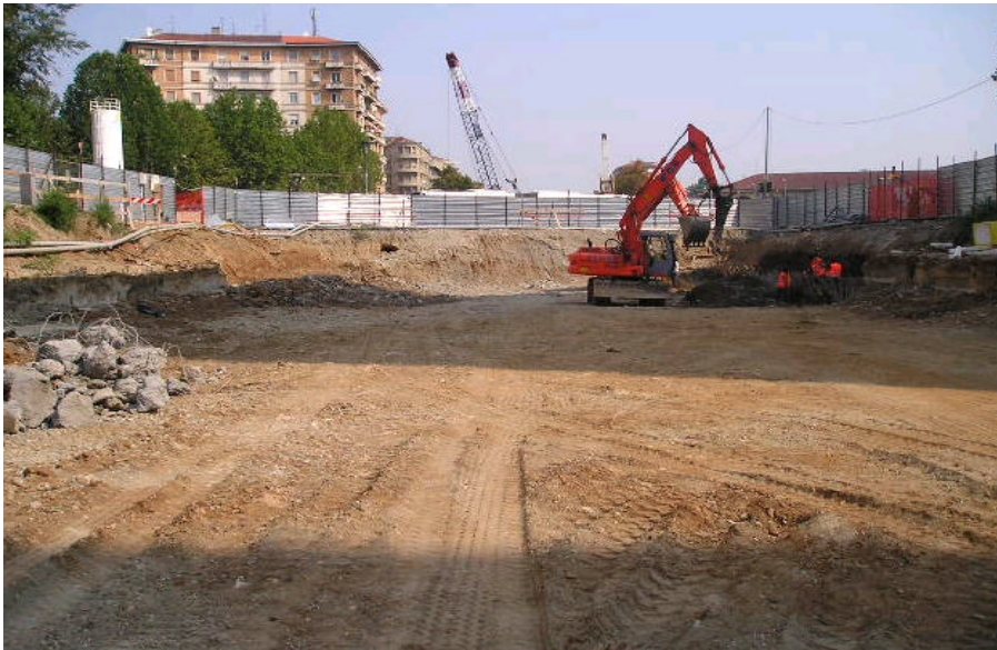
Foto 189-190 : scavo di approfondimento lungo la rampa su c.so Trapani
