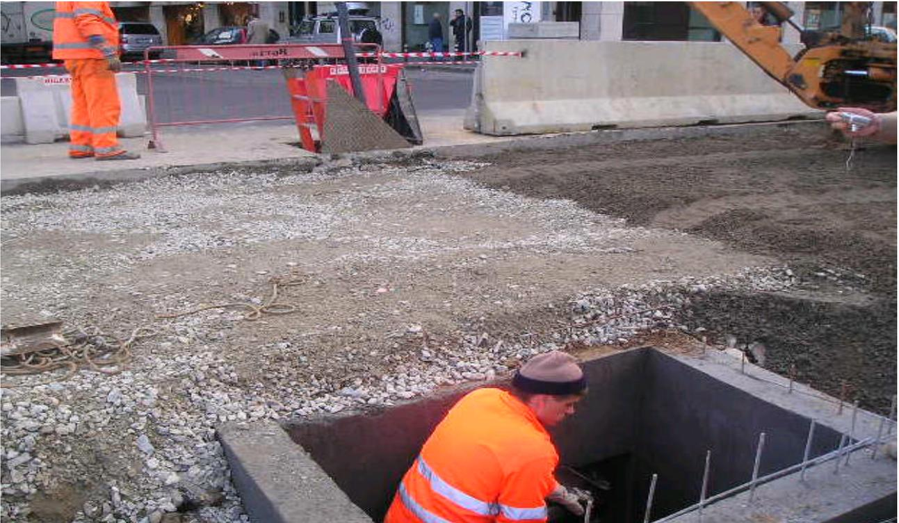
Foto 215-216 : inserimento cavi (TELECOM) cameretta impalcato lato ovest di c.so Trapani
