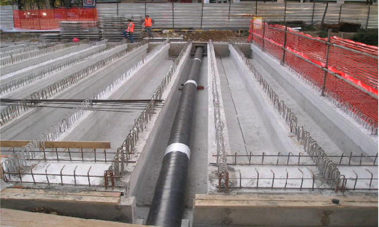
Foto 213-214 : preparazione e posa tubi (AES) impalcato lato c.so Trapani
