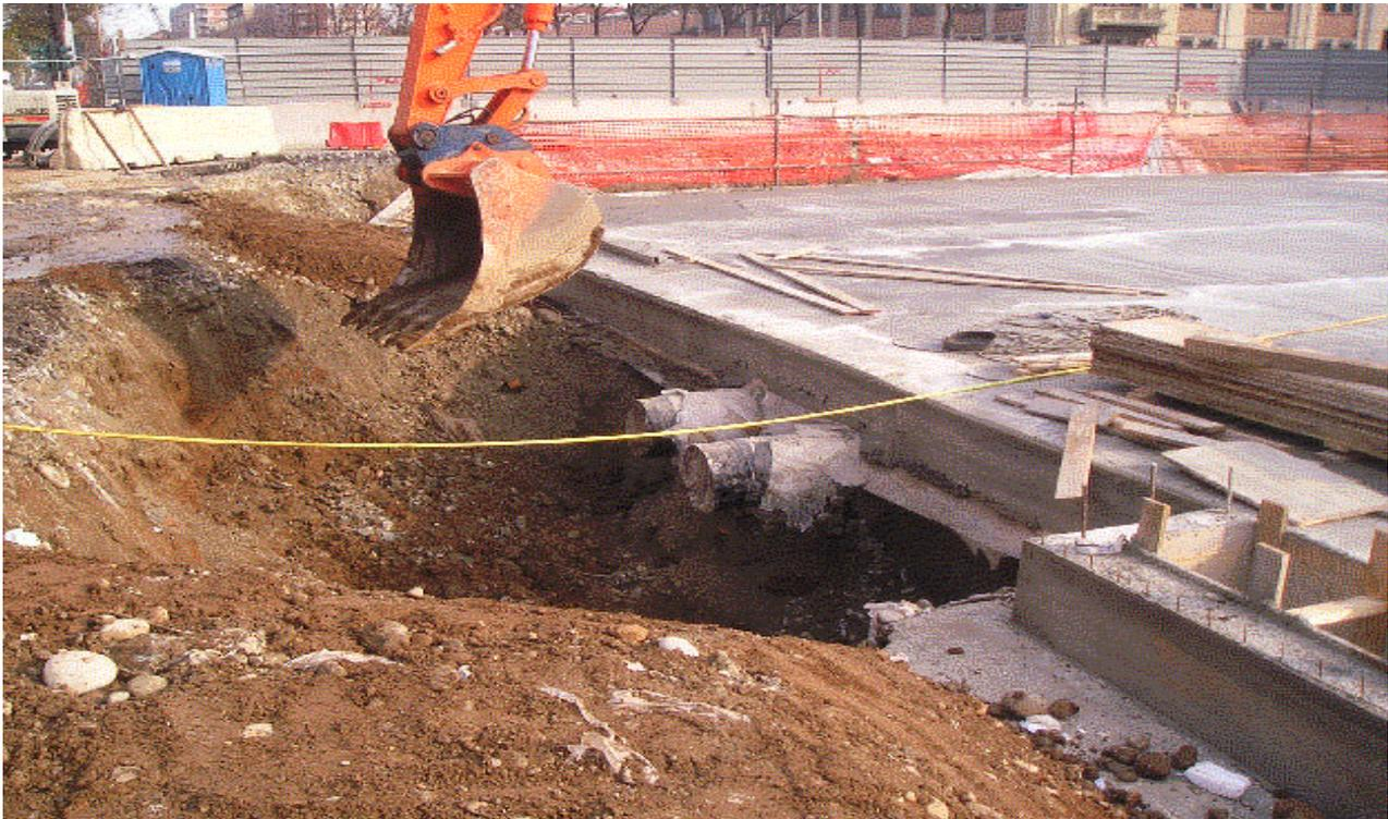
Foto 217-218 : preparazione e posa tubi (SMAT) impalcato lato c.so Trapani
