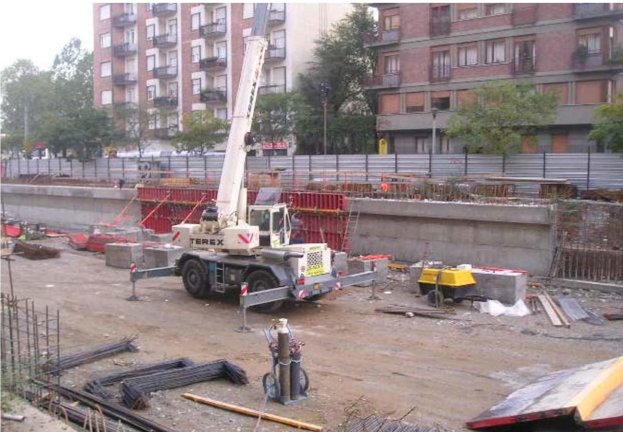
Foto 231-232 : getto in opera del tratto terminale dei diaframmi e delle fioriere lungo il lato est della rampa su c.so Trapani
