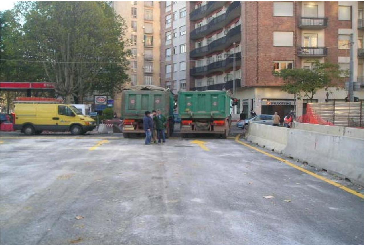
Foto 235-236: stesa del misto cementato e del binder sull'impalcato lato c.so Trapani – fase 1
