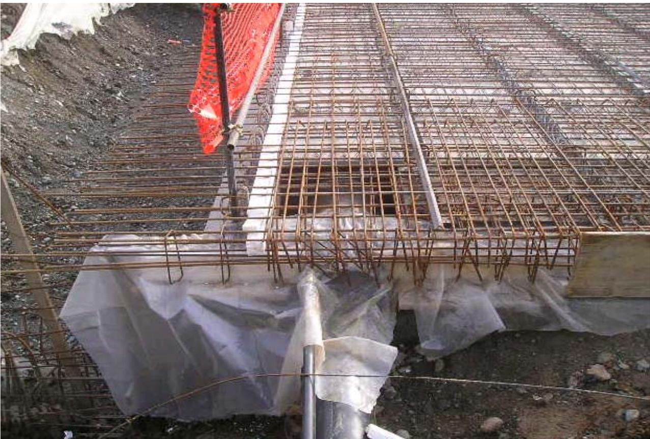
Foto 239-240: posa dell'armatura ed attraversamento sottoservizi impalcato su piazza Rivoli – fase 1
