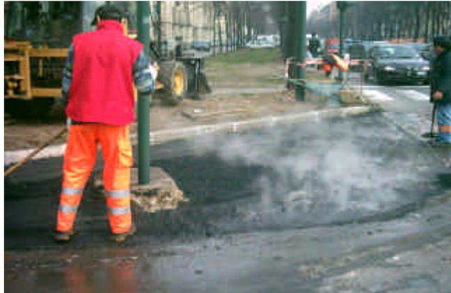
Foto 9-10 :sagomatura banchina spartitraffico ovest incrocio c.so Lecce/via Rosolino Pilo
