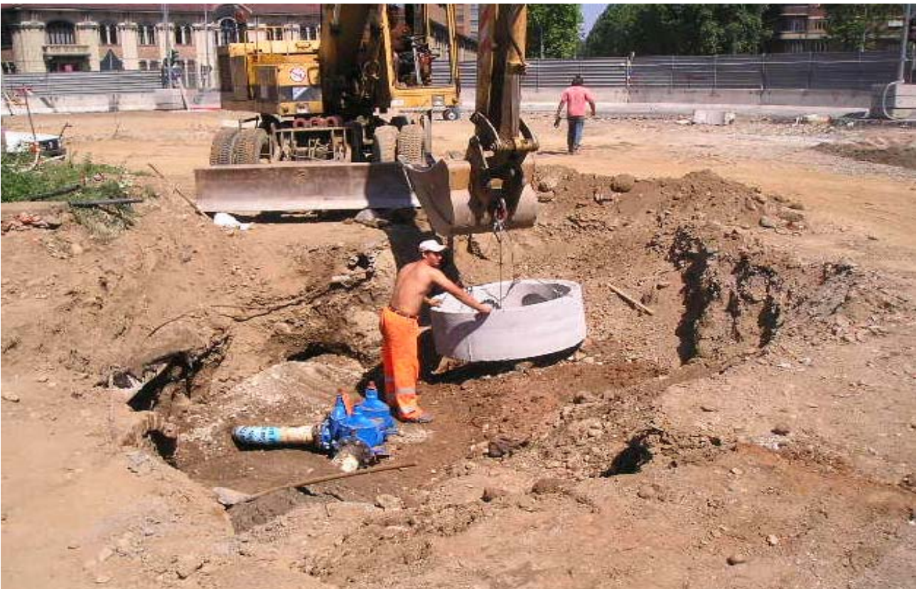
Foto 163-164 : adeguamento rete dell'acquedotto in piazza Rivoli (SMAT S.p.A.)
