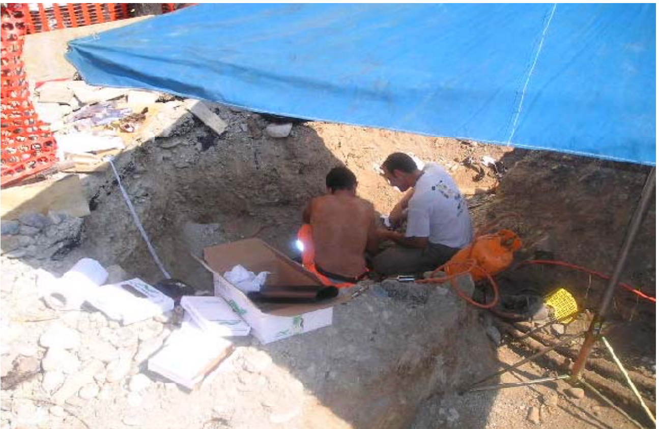
Foto 167-168 : adeguamento rete distribuzione in corso Lecce (A.E.M. S.p.A.)
