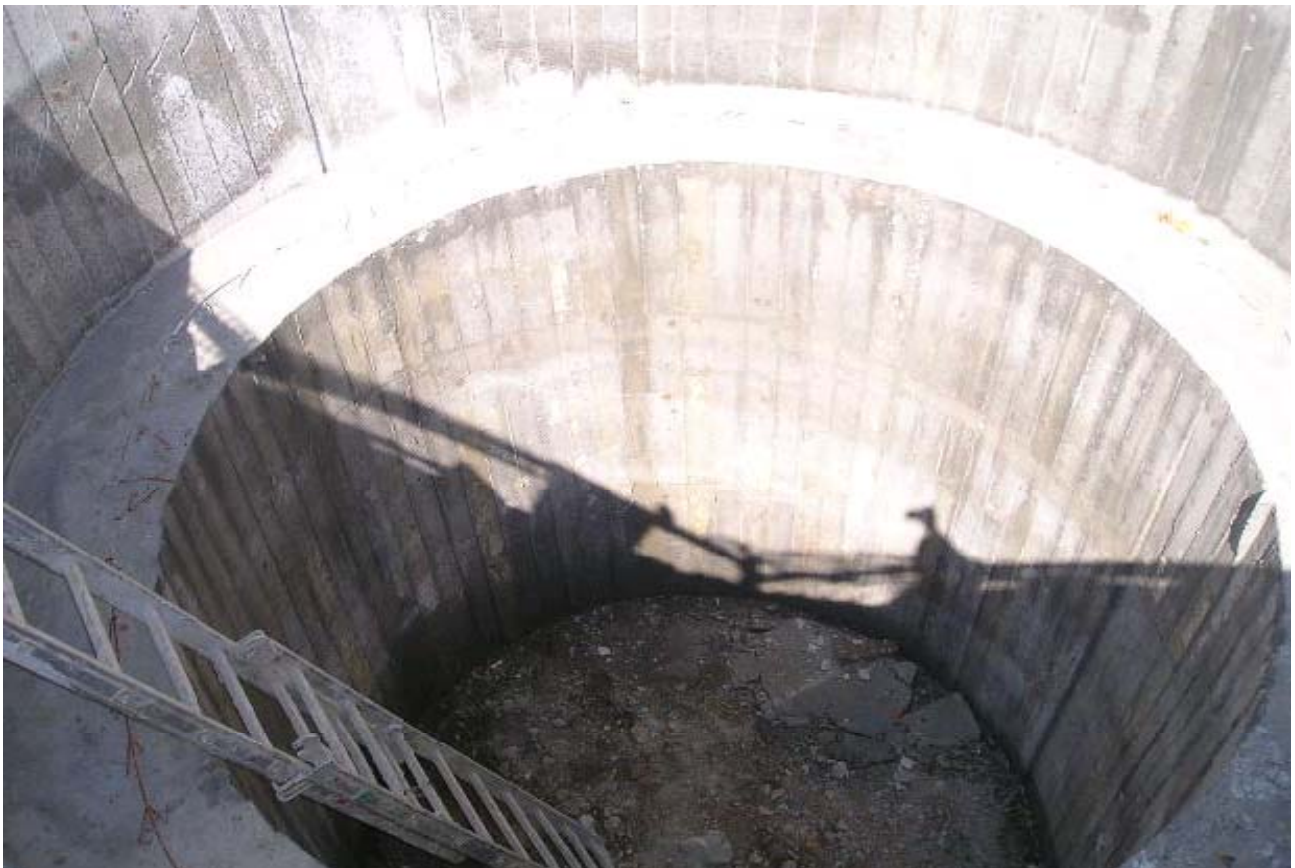
Foto 161-162 : realizzazione stazione di pompaggio in piazza Rivoli
