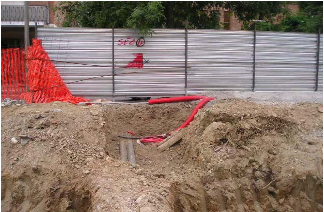
Foto 165-166 : adeguamento rete distribuzione in corso Trapani (A.E.M. S.p.A.)
