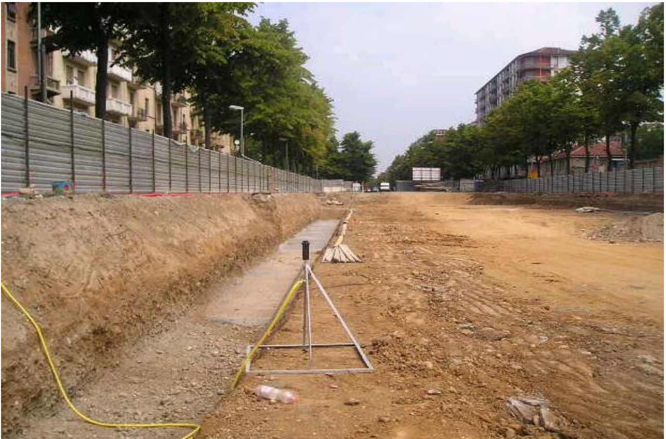
Foto 173-174 : installazione di innaffiatoi rotanti in c.so Trapani/c.so Lecce
