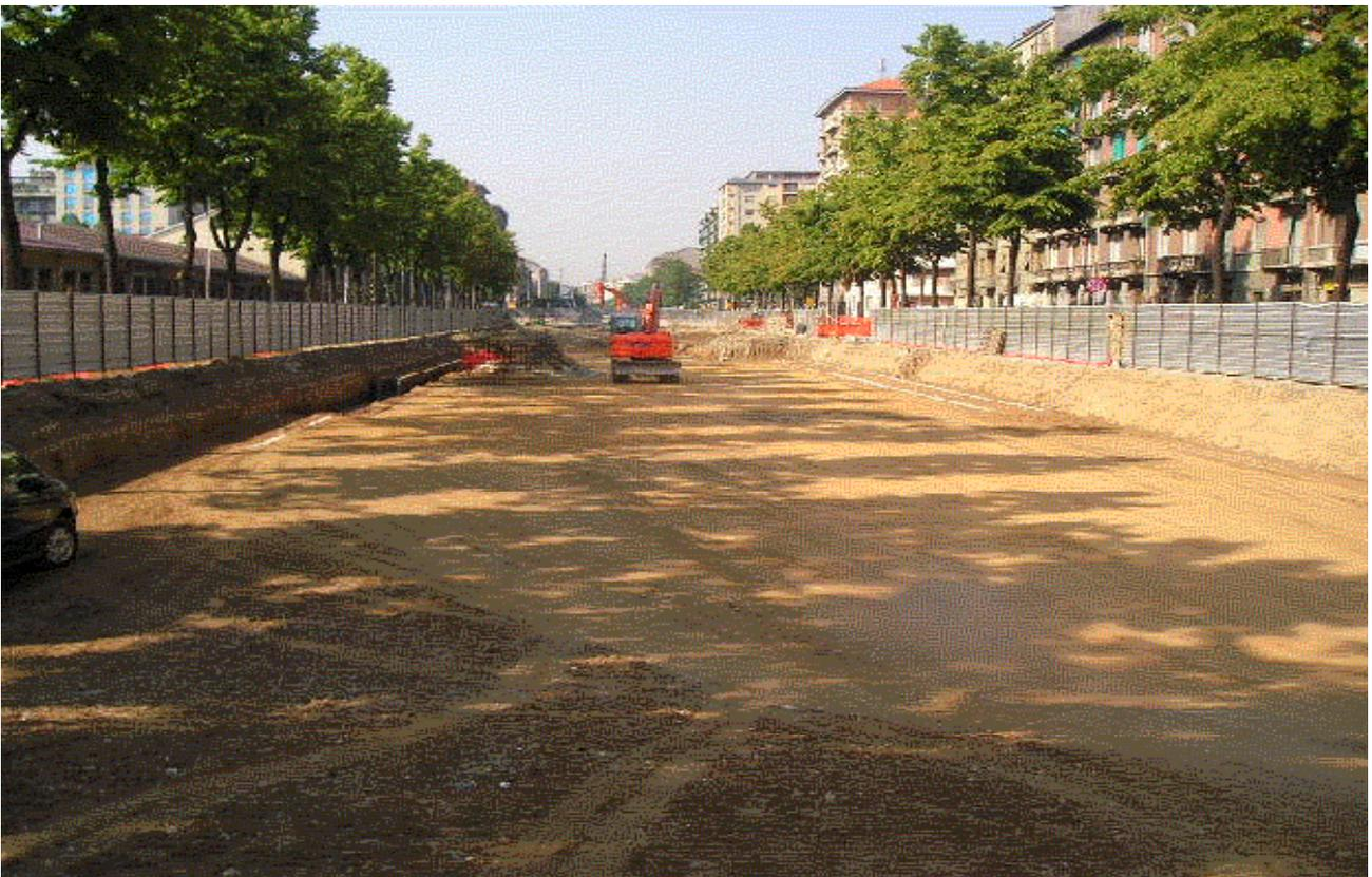
Foto 153-154 : scavo di sbancamento per la rampa su c.so Lecce
