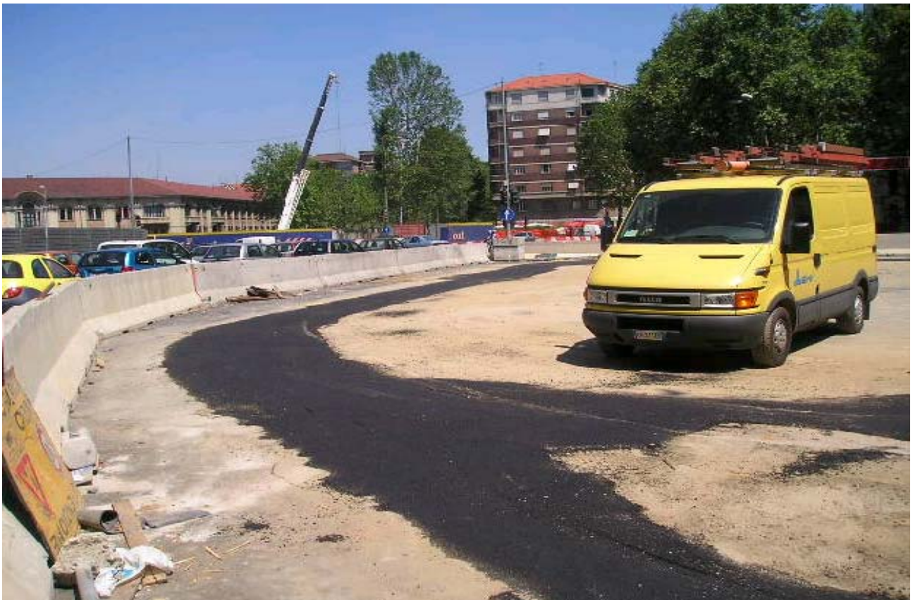
Foto 137-138 : lavori di adeguamento della rete Telecom
