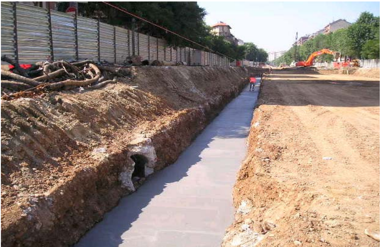
Foto 135-136 : scavo di sbancamento in piazza Rivoli
