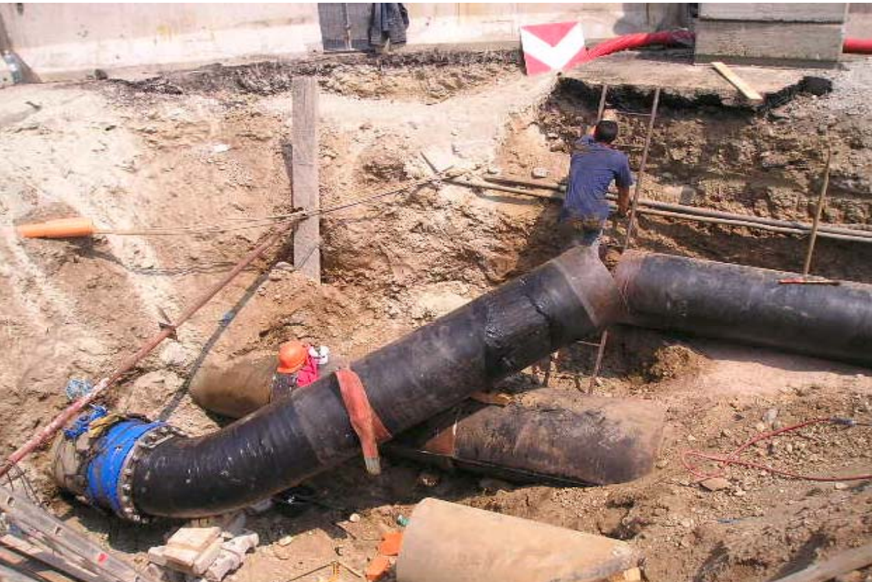
Foto 141-142 : lavori di adeguamento della rete dell'acquedotto (SMAT)
