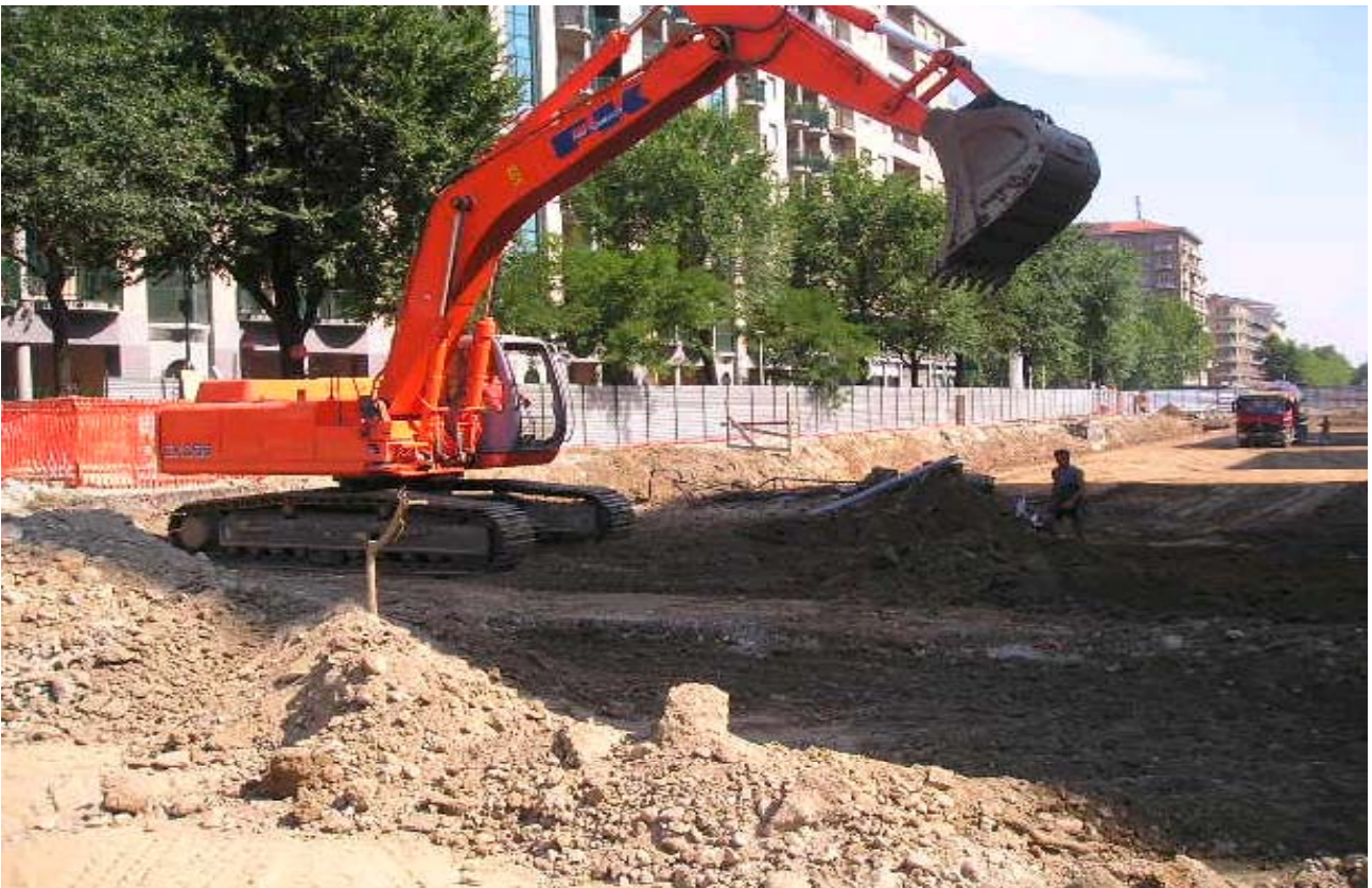
Foto 133-134 : scavo di sbancamento in piazza Rivoli
