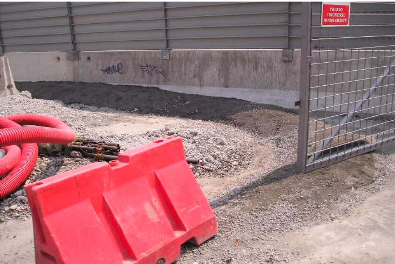
Foto 139-140 : lavori di adeguamento della rete AEM-Distribuzione
