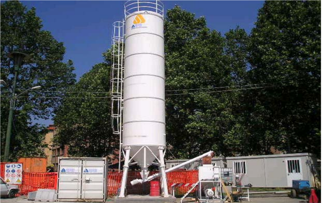
Foto 131-132 : costruzione stazione di betonaggio in piazza Rivoli
