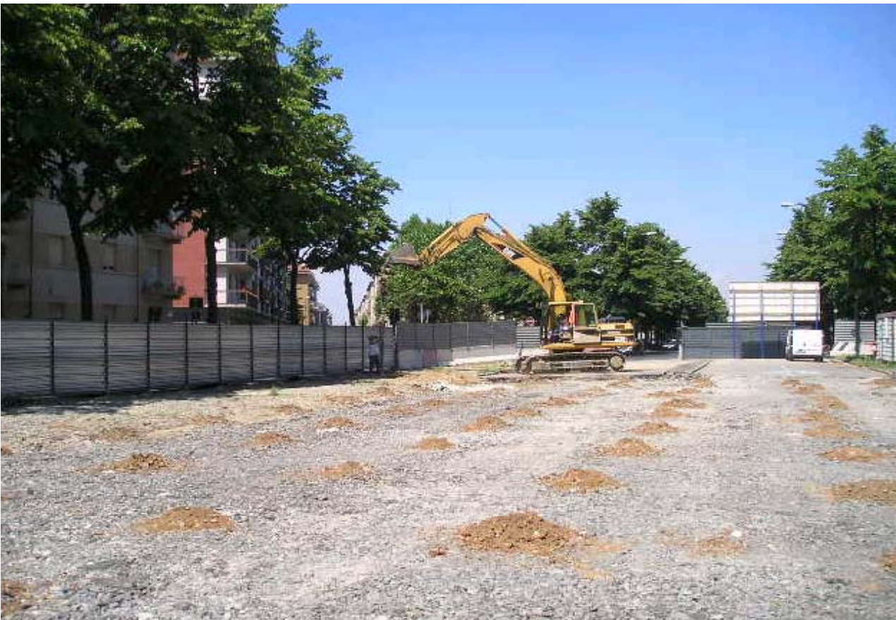
Foto 125-126 : esecuzione bonifica bellica profonda in corso Lecce
