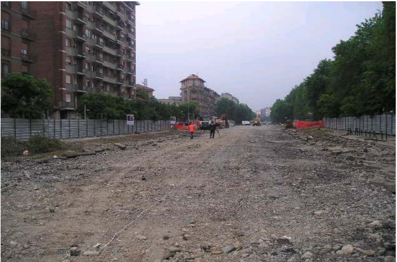
Foto 121-122 : esecuzione bonifica bellica superficiale
