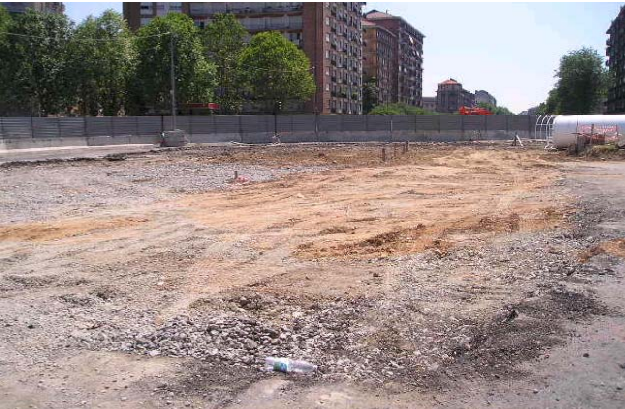
Foto 127-128 : esecuzione bonifica bellica profonda in piazza Rivoli
