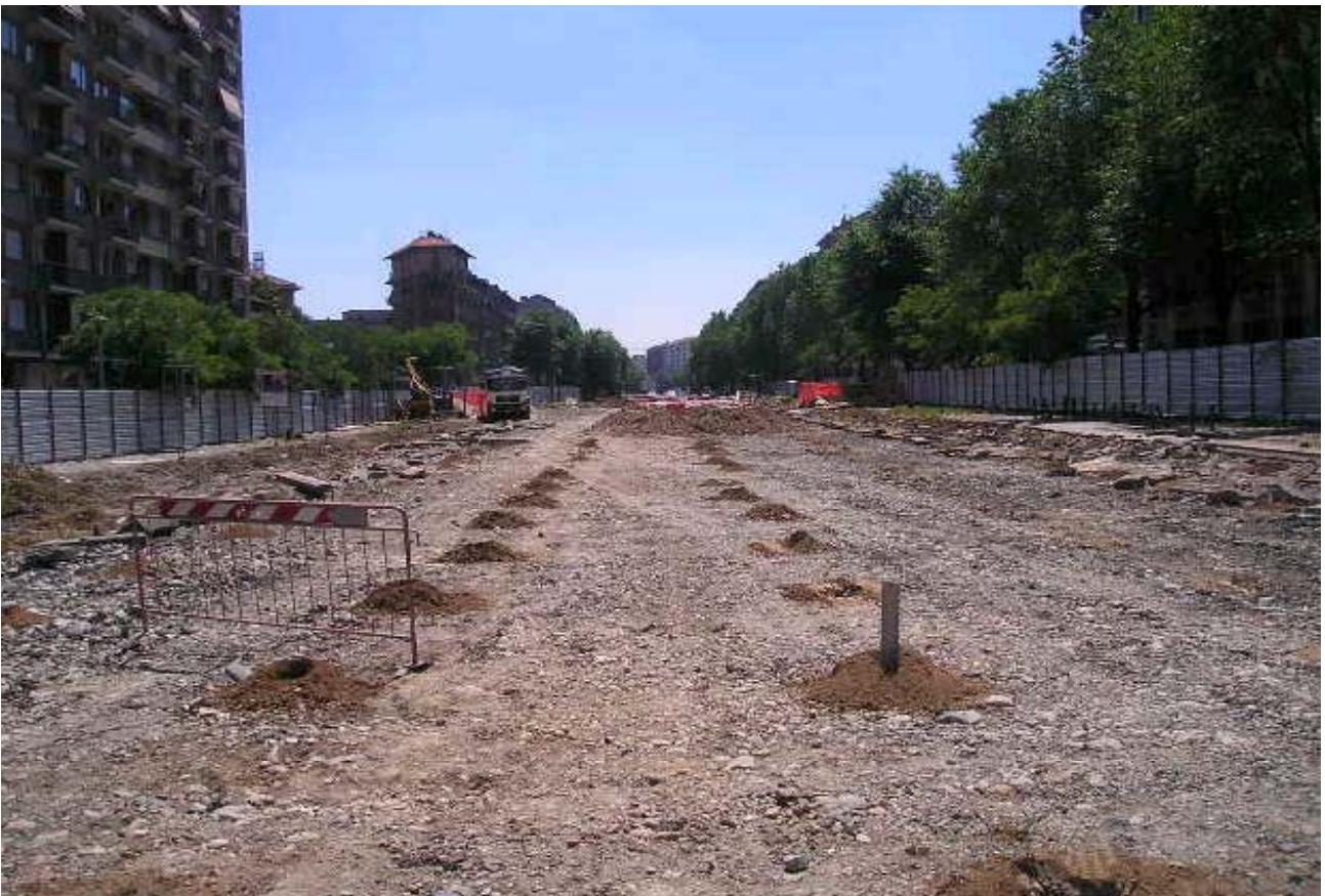
Foto 123-124 : esecuzione bonifica bellica profonda in corso Trapani
