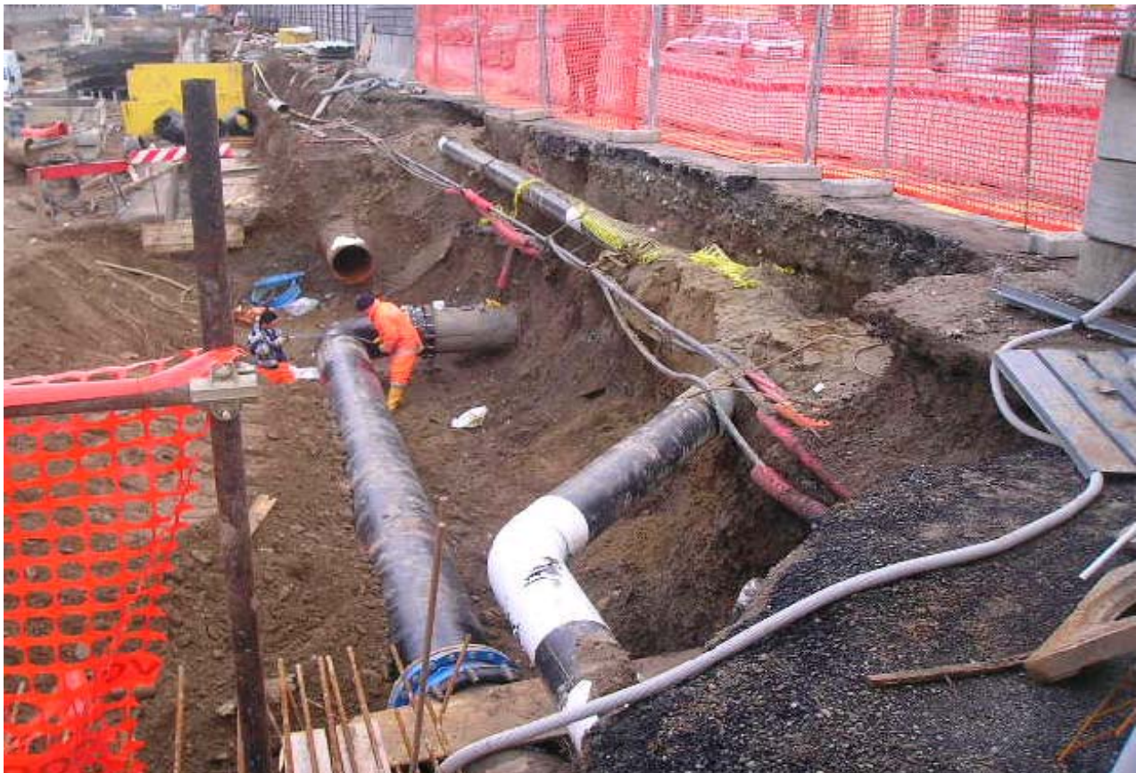
Foto 281-282: adeguamento sottoservizi Smat su c.so Lecce
