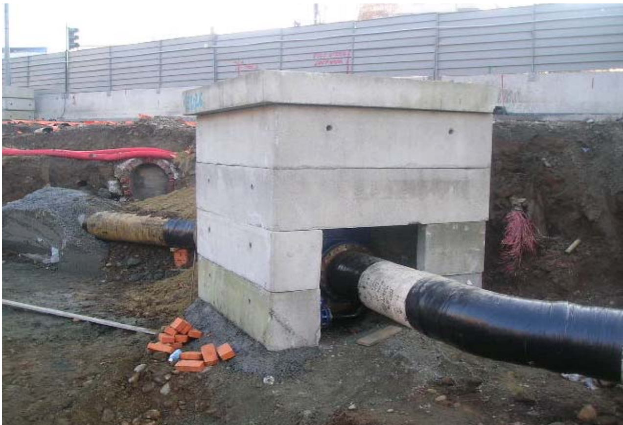
Foto 279-280: adeguamento sottoservizi Smat su piazza Rivoli
