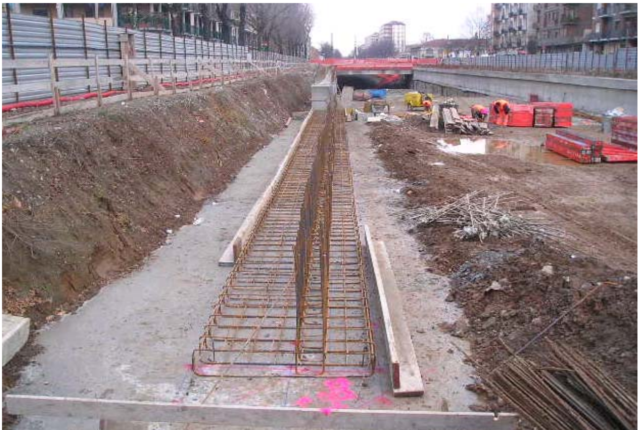
Foto 273-274: armatura muri rampa su c.so Trapani
