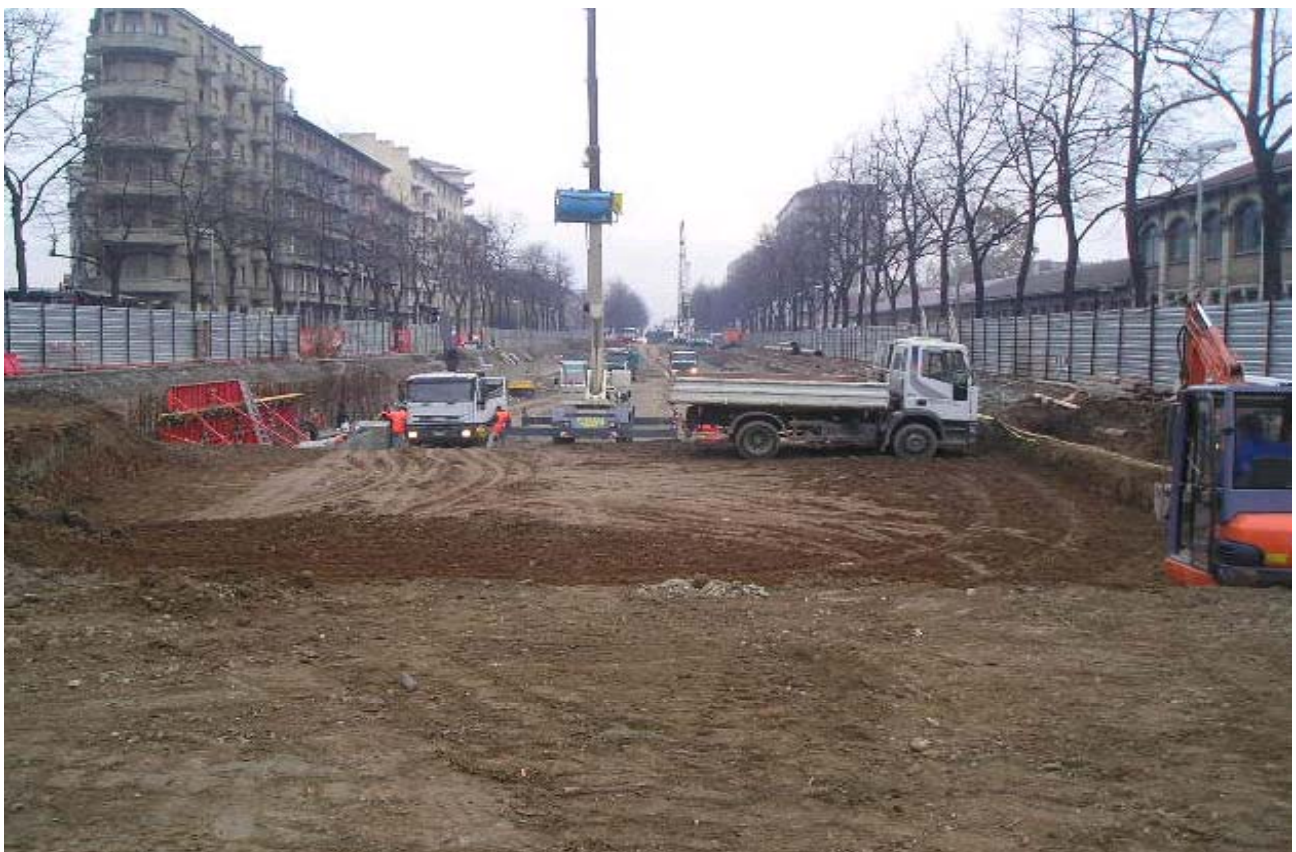
Foto 263-264: scavo di sbancamento rampa su c.so Lecce
