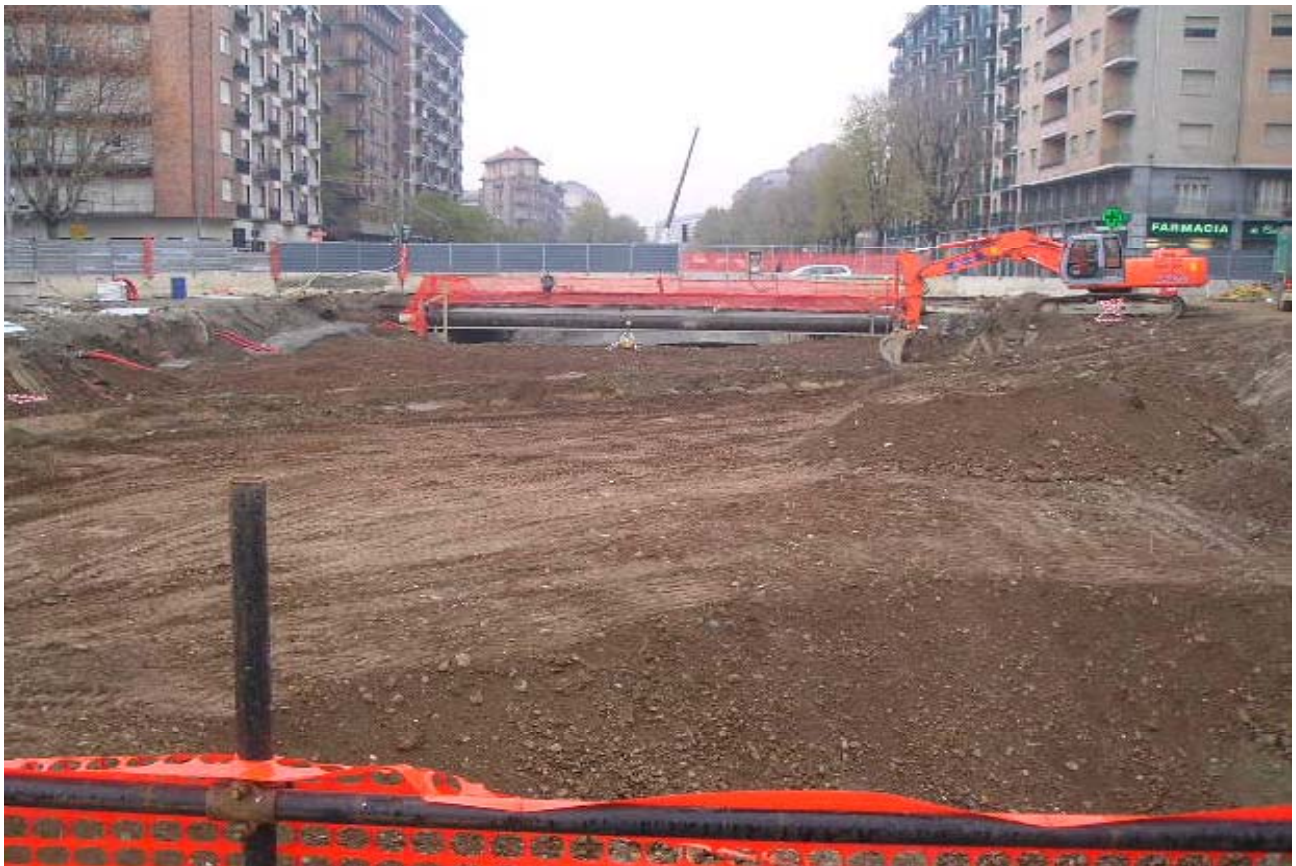
Foto 265-266: scavo di sbancamento parte centrale di piazza Rivoli
