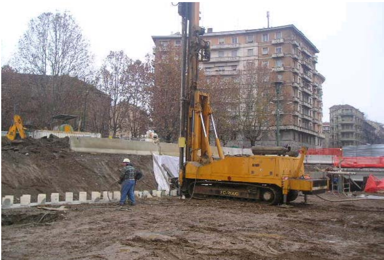
Foto 271-272: realizzazione micropali per sostegno pareti di scavo su piazza Rivoli
