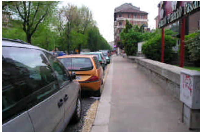
Foto 41-42 :riafaltatura marciapiedi lungo il controviale ovest di c.so Trapani
