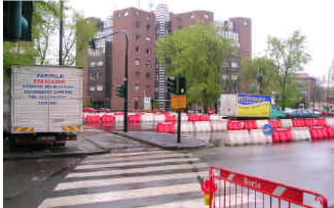
Foto 47-48 :chiusura attraversamento di c.so Trapani in corrispondenza di via Lera-via Capriolo
