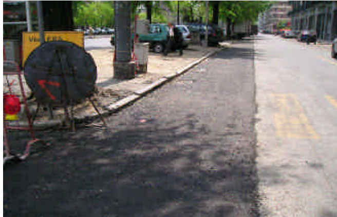
Foto 39-40 :ripristino pavimentazione stradale sul controviaie ovest di corso Trapani
