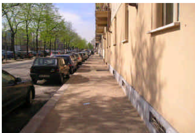
Foto 43-44 :riafaltatura marciapiedi lungo il controviaie ovest di c.so Lecce
