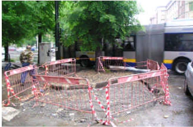
Foto 55-56 : risagomatura banchina all'incrocio c.so Trapani-via Bardonecchia
