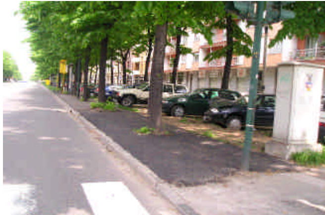
Foto 57-58 : ripristino pavimentazione nuove fermate autobus (c.so Lecce)
