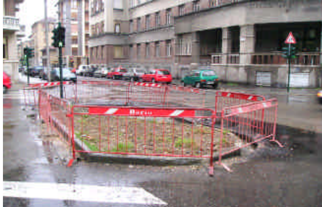
Foto 53-54 : risagomatura banchina all'incrocio c.so Trapani-via Bardonecchia
