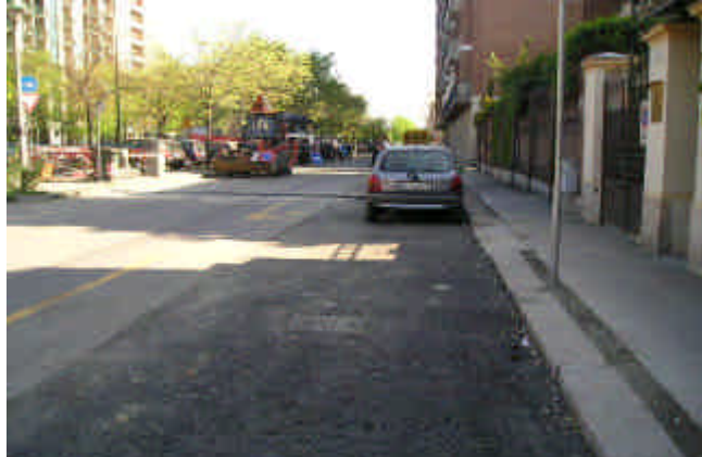
Foto 31-32 : rettifica marciapiedi controviale est di c.so Trapani
