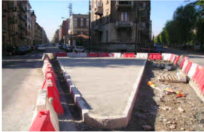
Foto 49-50 :realizzazione nuovo spartitraffico all'incrocio tra c.so Trapani-via Lera
