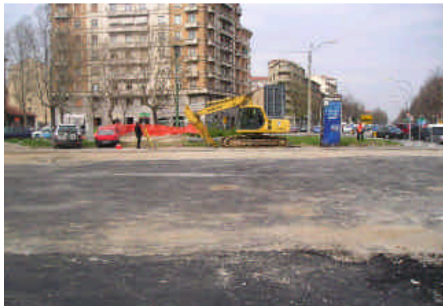
Foto 69-70 :tracciamento vertici impalcati lato nord e lato sud
