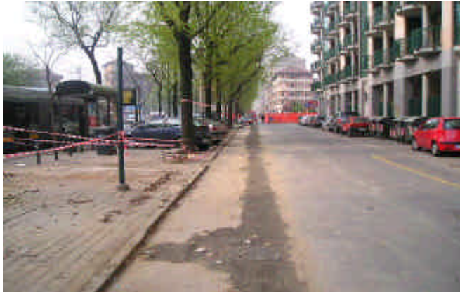
Foto 33-34 :posa cavidotto impianto illuminazione controviaie ovest di c.so Trapani
