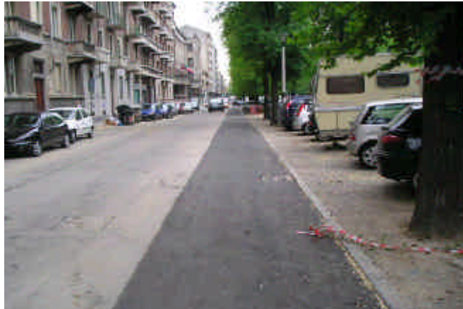
Foto 37-38 : ripristino pavimentazione sul controviale est di corso Tra pani
