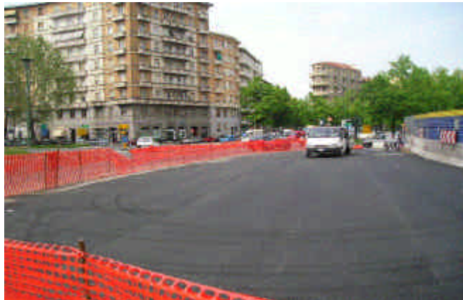
Foto 65-66 :arretramento cantiere metropolitana in piazza Rivoli
