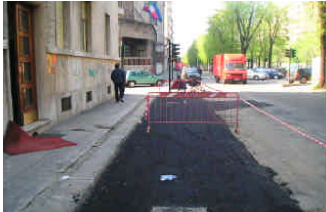
Foto 35-36 : posa cavidotto impianto illuminazione controviaie est di c.so Trapani
