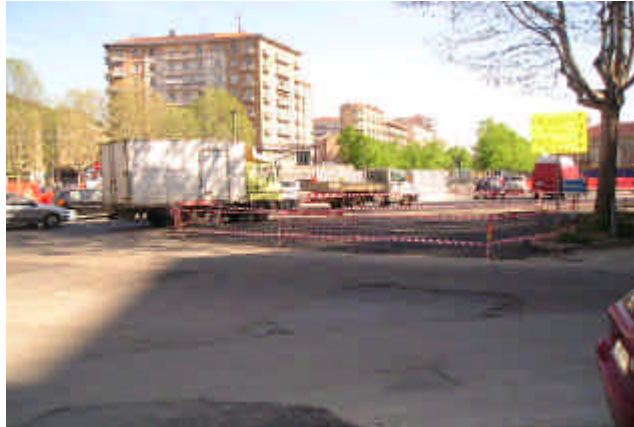
Foto 63-64: rifacimento pavimentazione stradale parte centrale di piazza Rivoli
