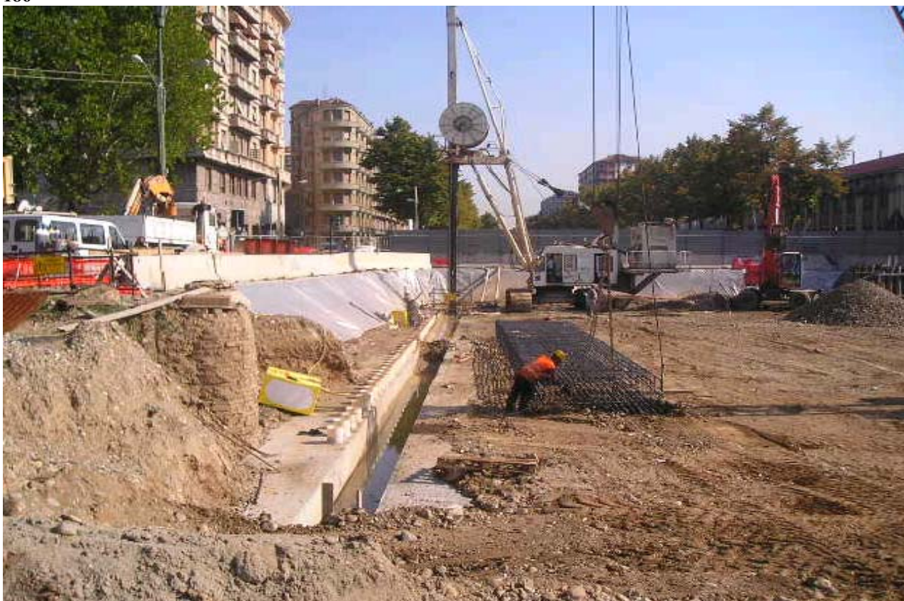
Foto 185-186 : realizzazione diaframmi impalcato su piazza Rivoli (1° fase)
