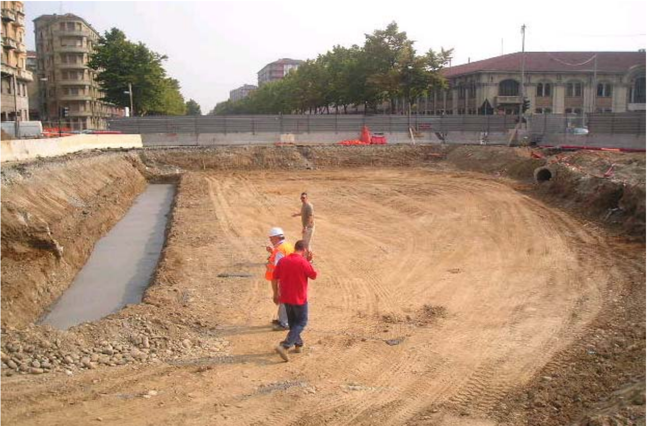
Foto 183-184 : realizzazione cordoli guida impalcato su piazza Rivoli (1° fase)
