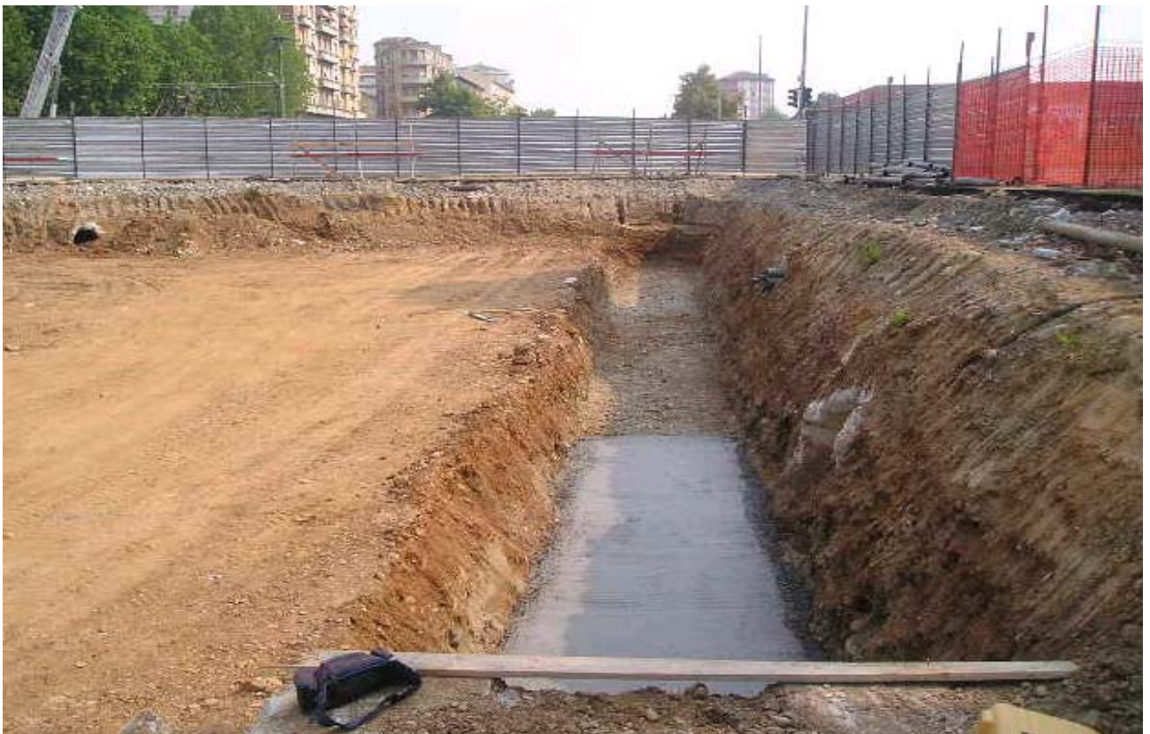
Foto 177-178 : realizzazione cordoli guida impalcato su c.so Trapani (1° fase)
