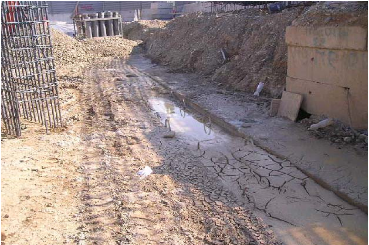
Foto 181-182 : realizzazione diaframmi lato ovest impalcato su c.so Trapani (1° fase)
