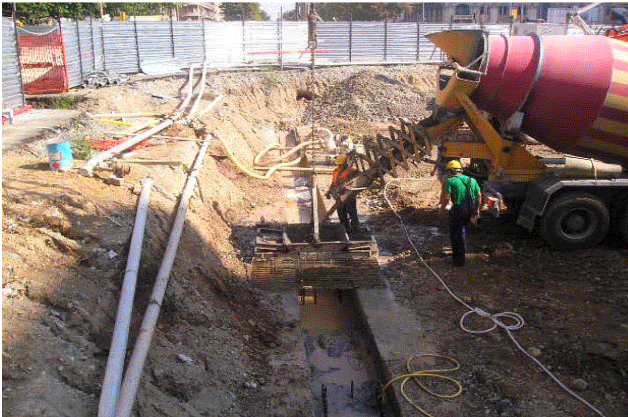
Foto 179-180 : realizzazione diaframmi lato est impalcato su c.so Trapani (1° fase)
