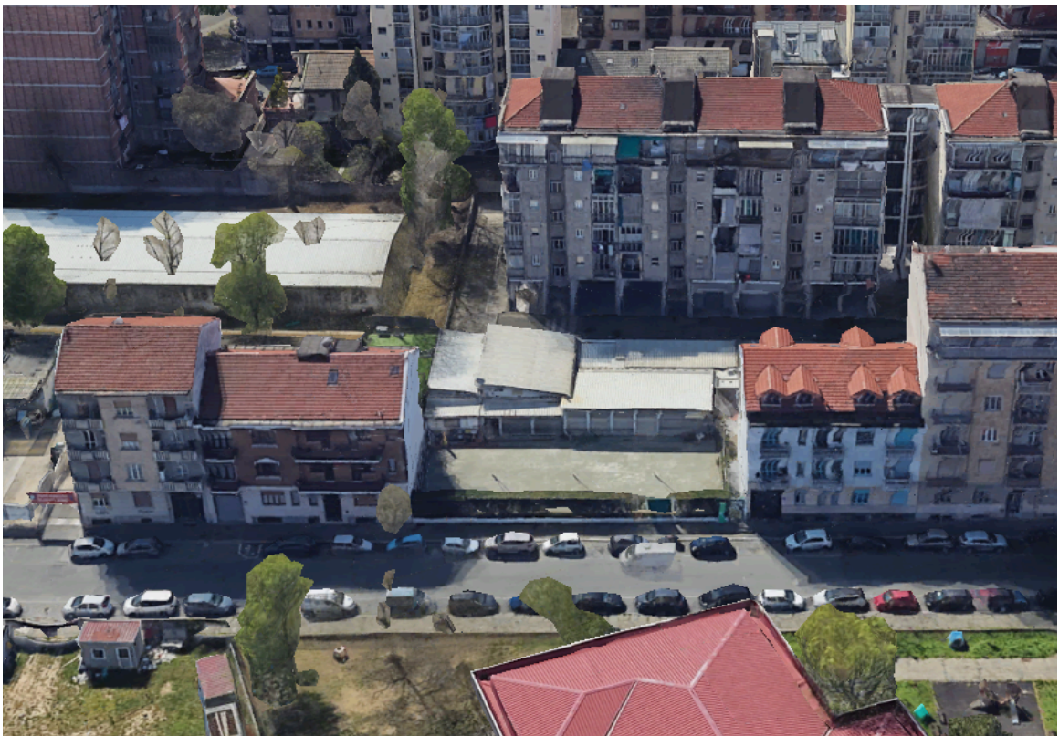
Vista impianto da Google earth
