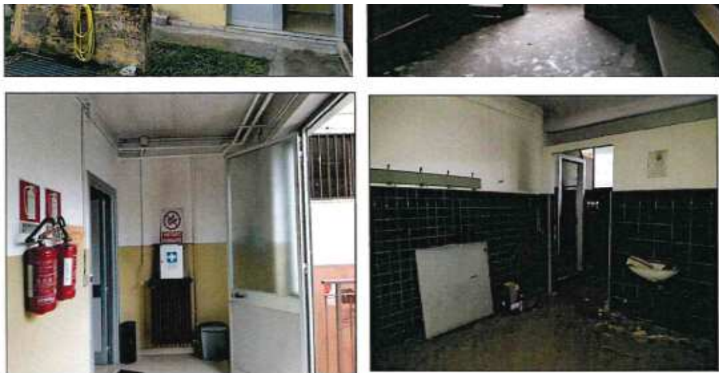
Vista ingresso ufficio, locale ufficio e servizio igienico annesso
