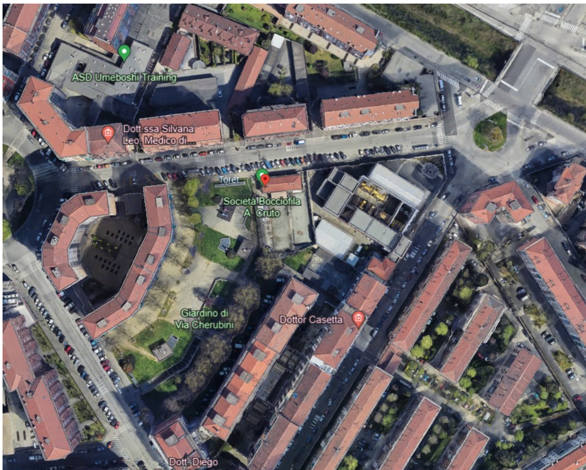
Vista impianto da Google earth
