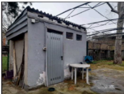
servizi igienici esterni
