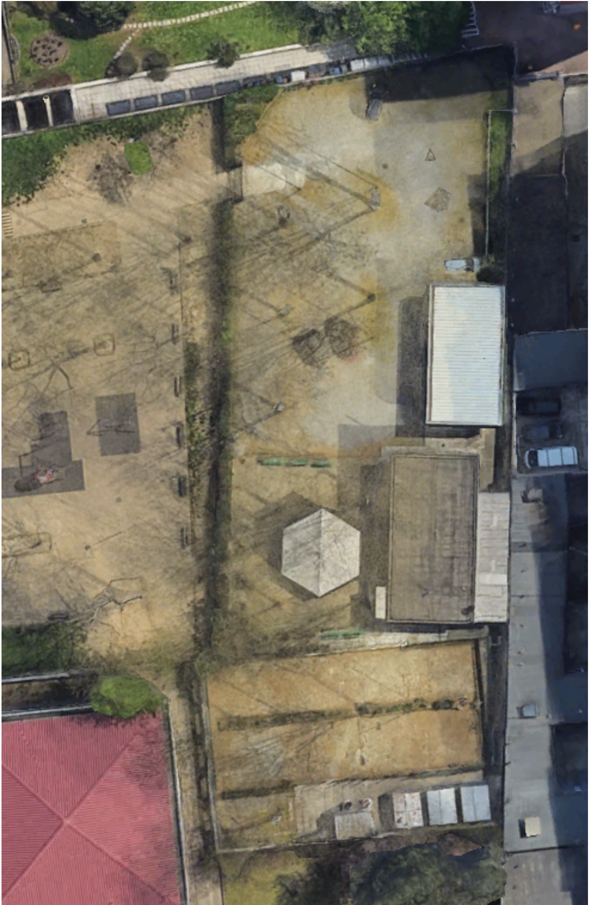
Vista aerea impianto
