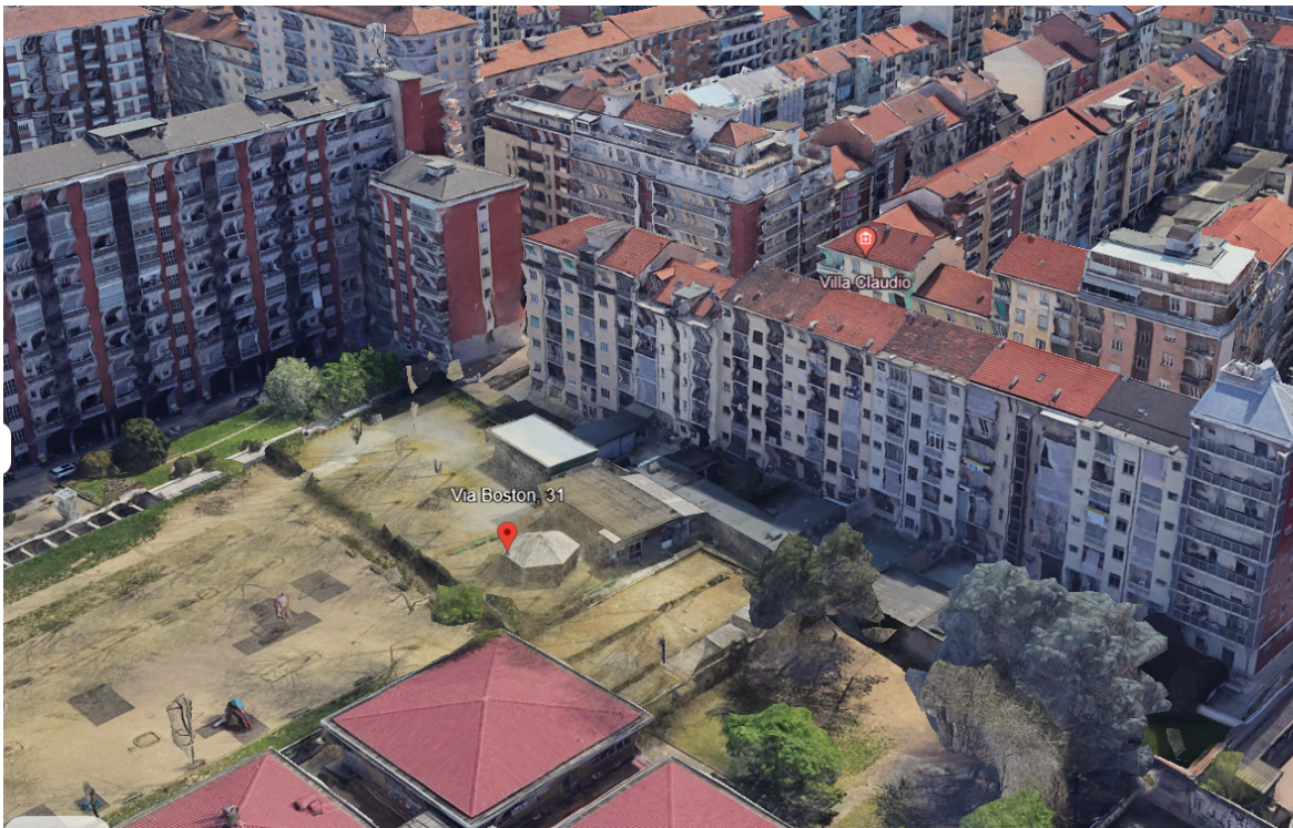
Vista impianto da Google earth
