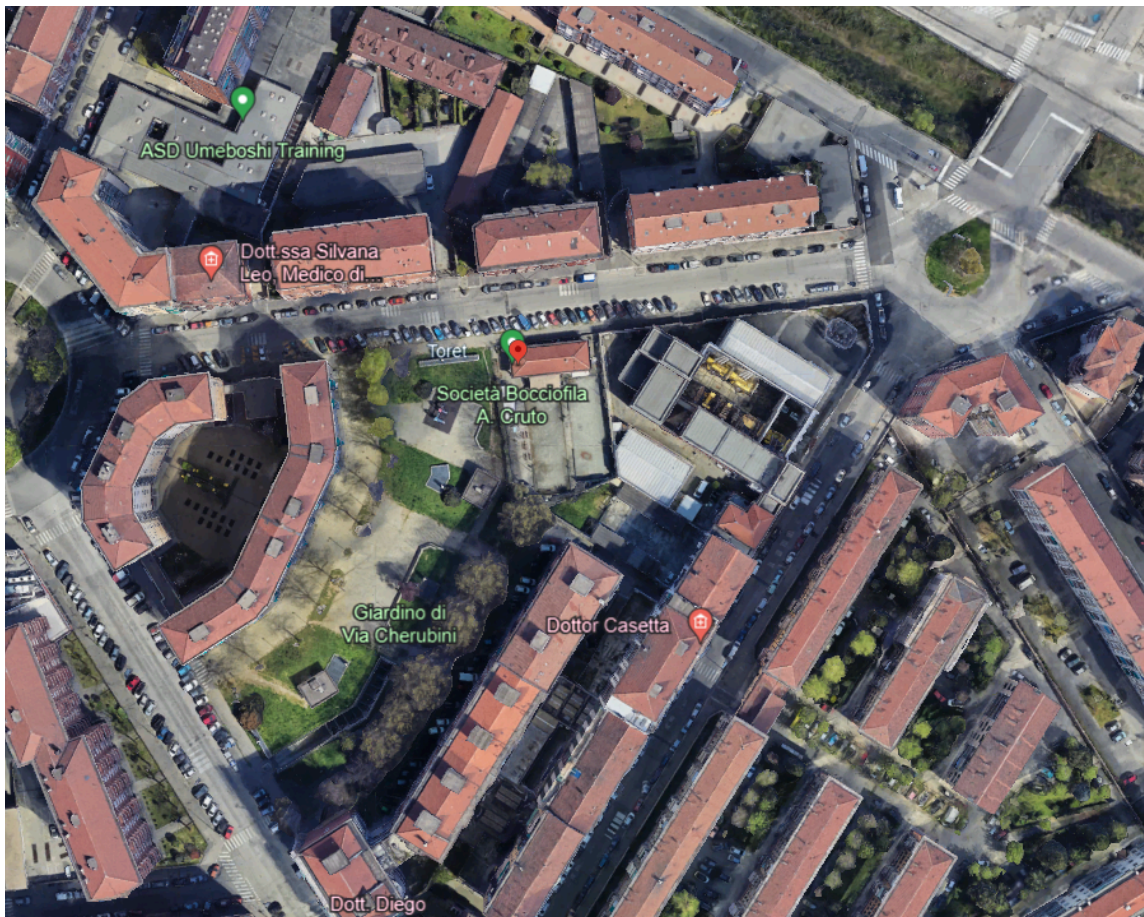
Vista impianto da Google earth
