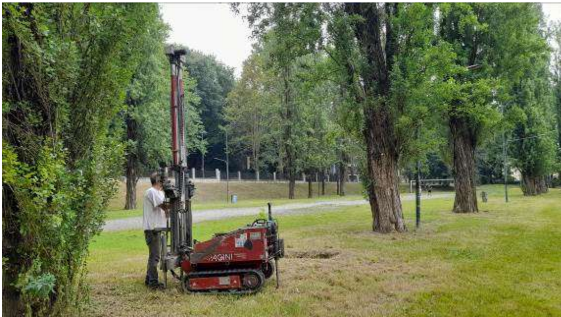
Figura 15 - Esecuzione della prova penetrometrica DIN3
