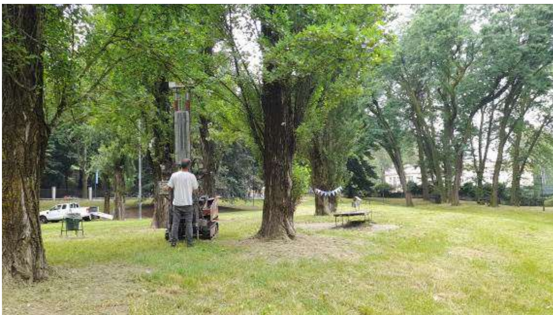
Figura 14 - Esecuzione della prova penetrometrica DIN2
