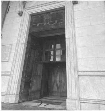
Dettaglio del portone e della bussola di ingresso
