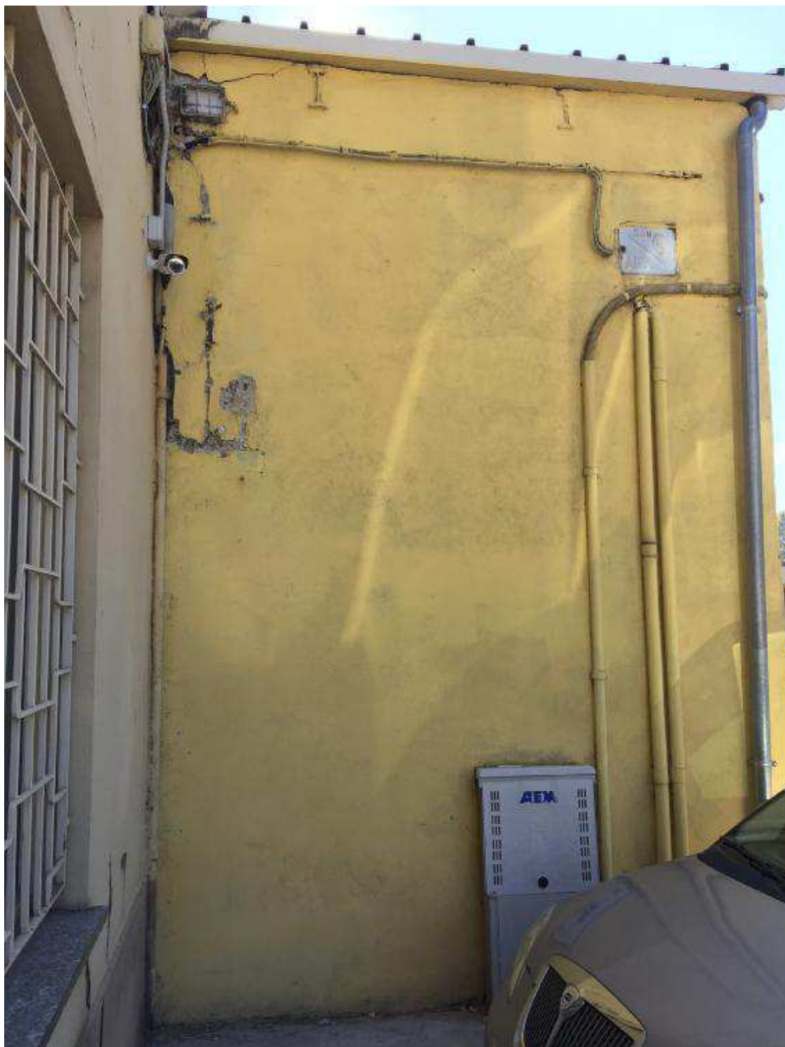
FOTOGRAFIA 1 : Vista fabbricato A
