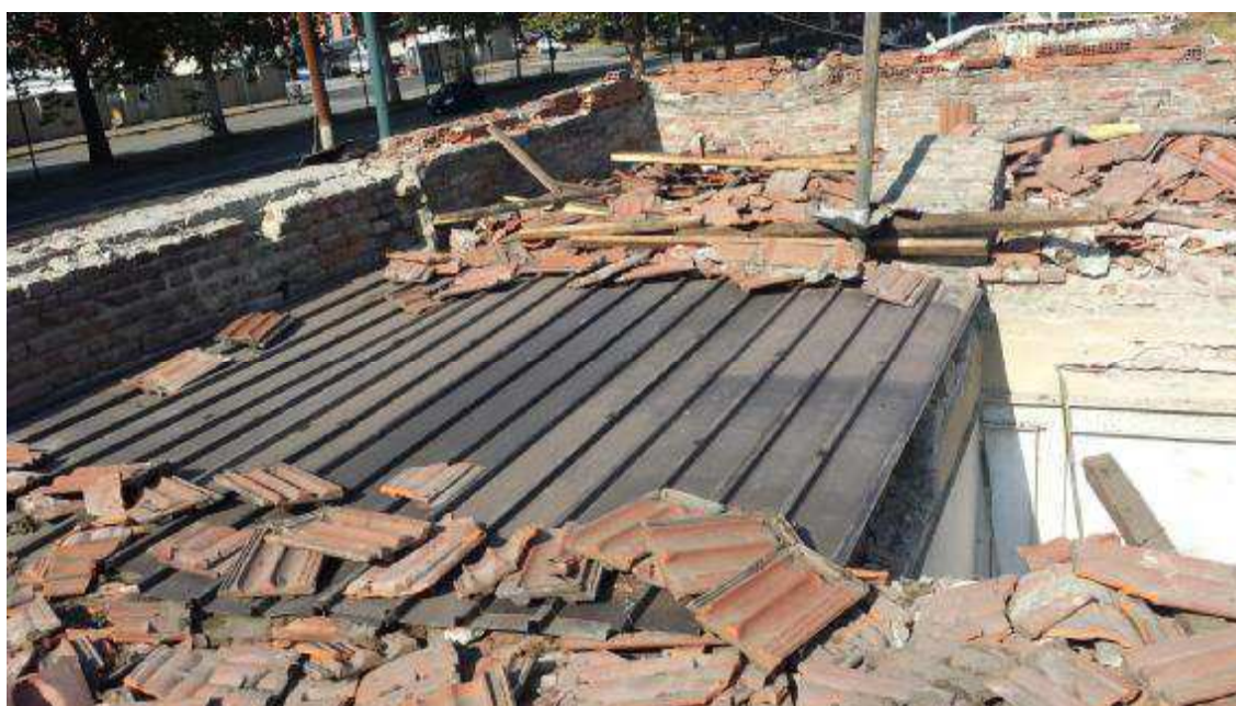
FOTOGRAFIA 3: Vista tetto fabbricato W
