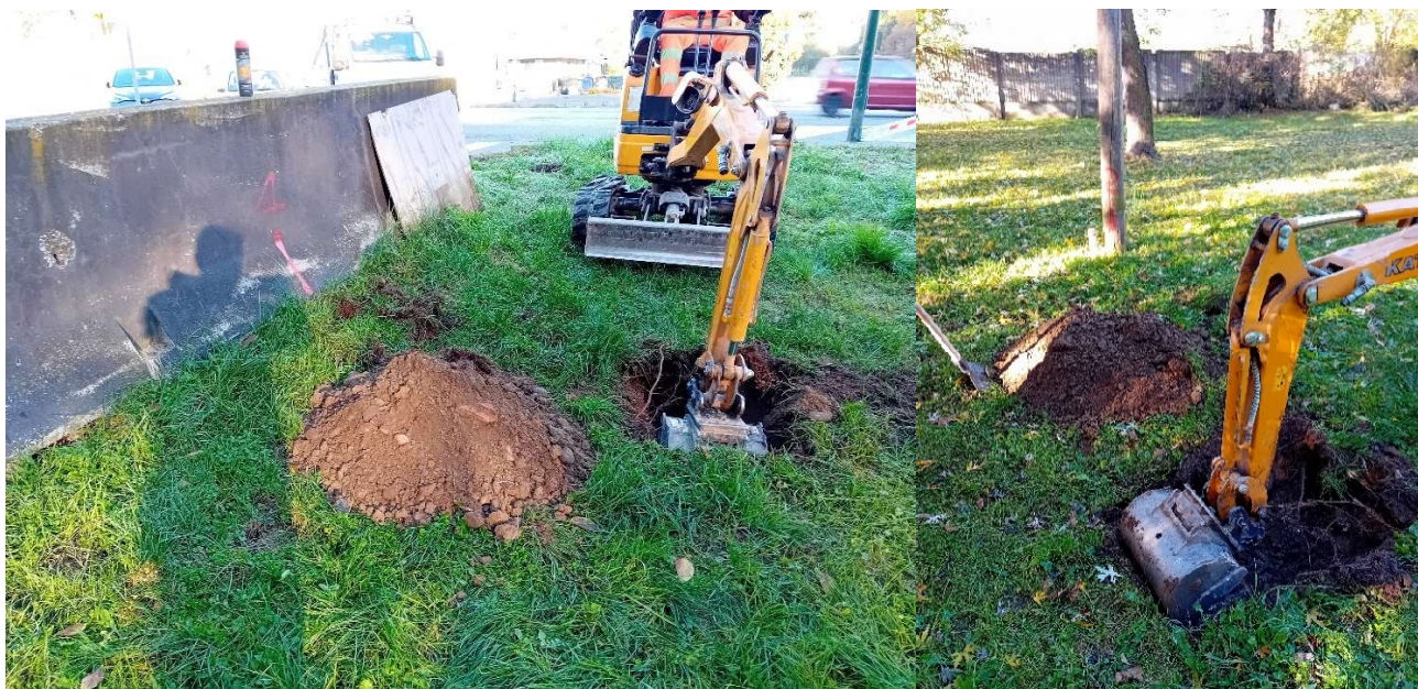
Figura 20 – Terreni prevalentemente limosi e sabbiosi riconducibili all'unità geotecnica U1 rinvenuti durante l'esecuzione dei sondaggi P1 (foto a sx, terreno di riporto antropico) e P2 (foto a dx, terreno naturale di copertura dei depositi fluviali CSN 2b ).
