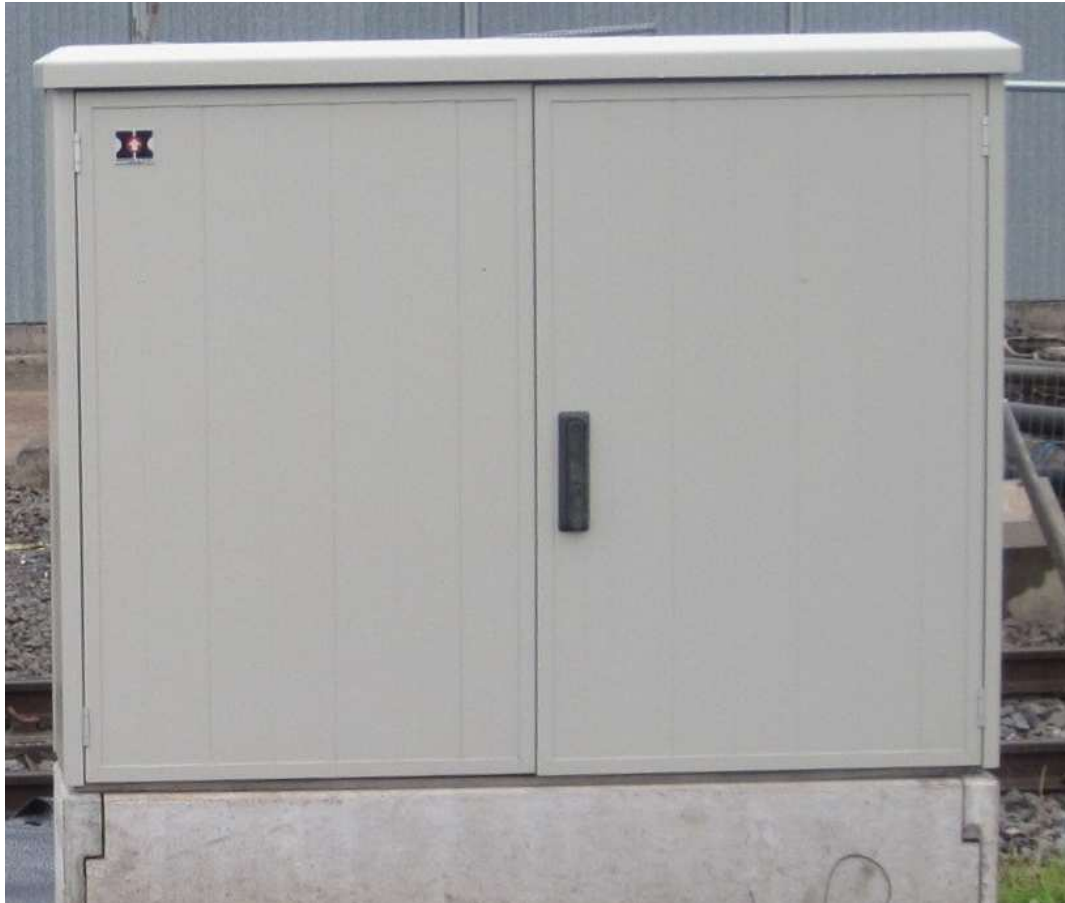
Figura – Armadio PPC attualmente in uso su rete Torino
